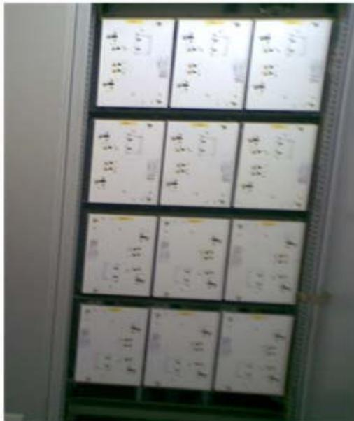
**Figure IV.3 : Armoire d'excitation statique**
