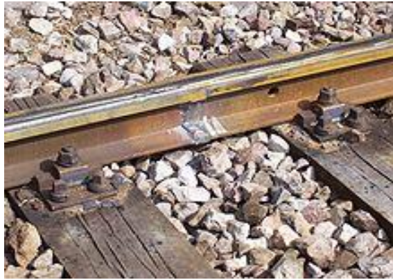
Figure VI-7: Barre soudée.
