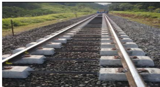
Figure VI-9: Traverse en béton armé.
