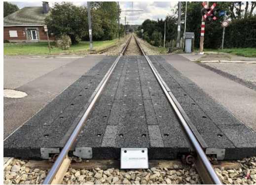
Figure X-3: Passage à niveau d'une voie ferrée.
