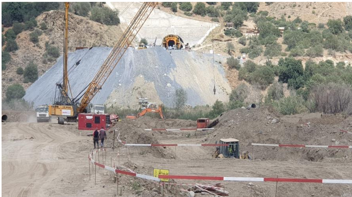
Figure X-4: Travaux de viaduc 44+095 (forage des pieux).
