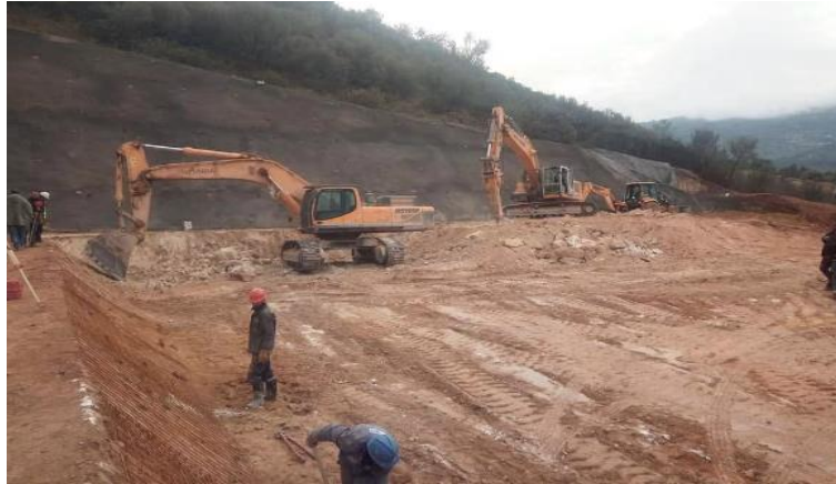
Figure IV-8:travaux de terrassement au pk 41.
