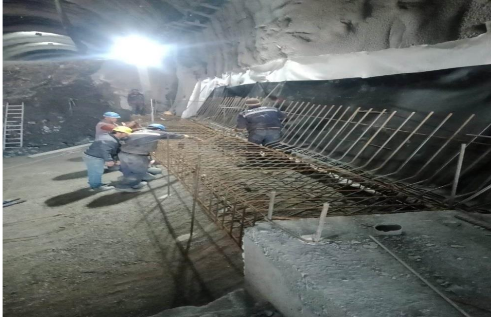
Figure X-5: Travaux de tunnel Sidi Aich (portail entrée).
