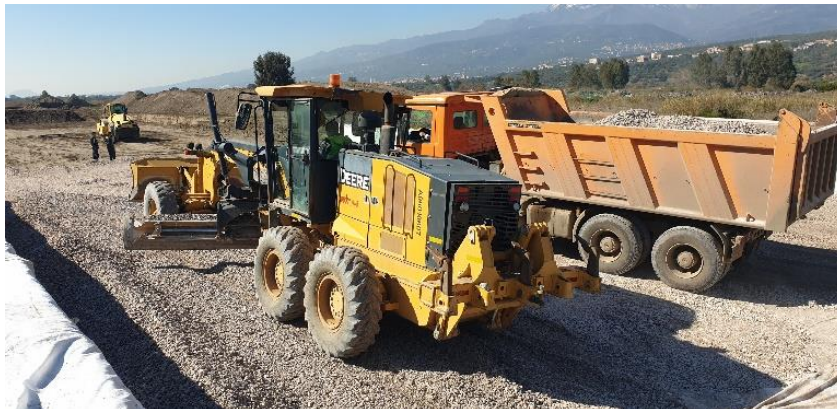
Figure IV-7: Travaux de terrassement au Pk38.
