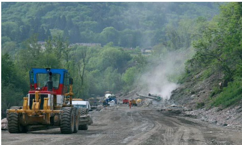
Figure IV-1: Exécution Travaux de terrassement.
