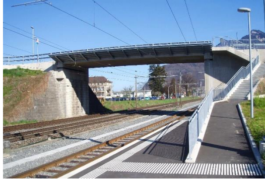
Figure X-1: Passage supérieur d'une voie ferrée.
