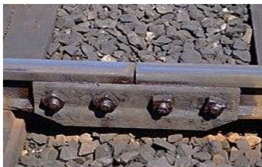
Figure VI-8: Assemblage par l'éclissage.
