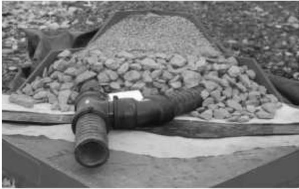
**Figure n°3** : Les différents composants d'un fond de casier.( GRELA R 2008)
