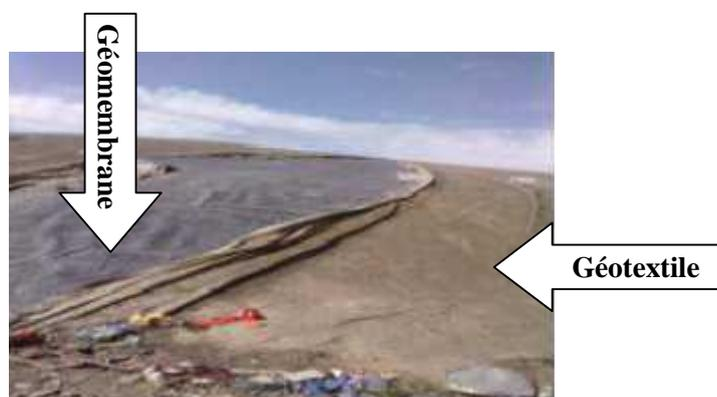
**Figure N°14** : Géomembrane et géotextile.
