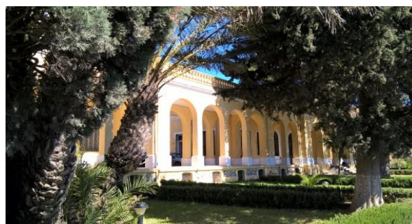
FIG 86 : Les locaux administratifs
