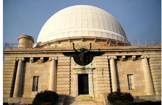
FIG 44 : Façade principale du grand équatorial l'observatoire de Nice.
