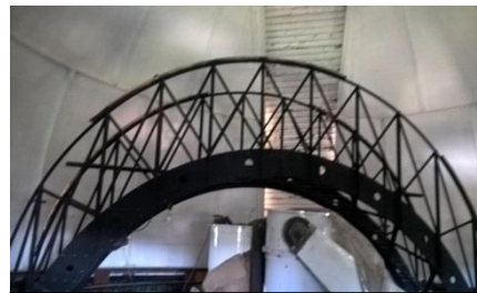
Passerelle métallique mobile sur rail. Photo prise le 25/04/2016.
