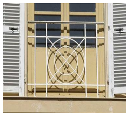
FIG 35 : Garde-corps à motif circulaire (symbole du Ciel), ailes nord et sud de la Bibliothèque, fenêtres du premier étage. Marc Heller © Observatoire de la Côte d'Azur
