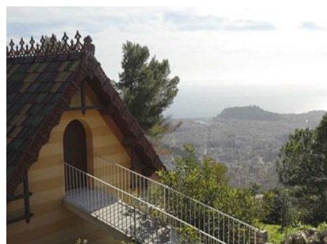
FIG 38 : Toitures à tuiles colorées et vernissées, Pavillon des écuries. Marc Heller © Observatoire de la Côte d'Azur
