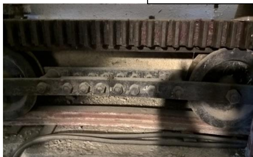
Détail du rail de la coupole mobile. Photo prise le 25/04/2016.
