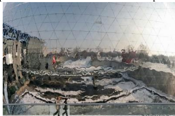
FIG 118 : Façade de la géode
