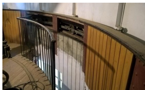
Accès au comble abritant le Télescope de Foucault. Photo prise le 25/04/2016.
