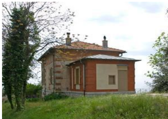
FIG 19 : Ancien pavillon de physique transformé en habitation, puis en bureaux. Marc Heller © Observatoire de la Côte d'Azur.
