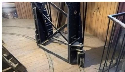
Détail du rail de la passerelle métallique. Photo prise le 25/04/2016.
