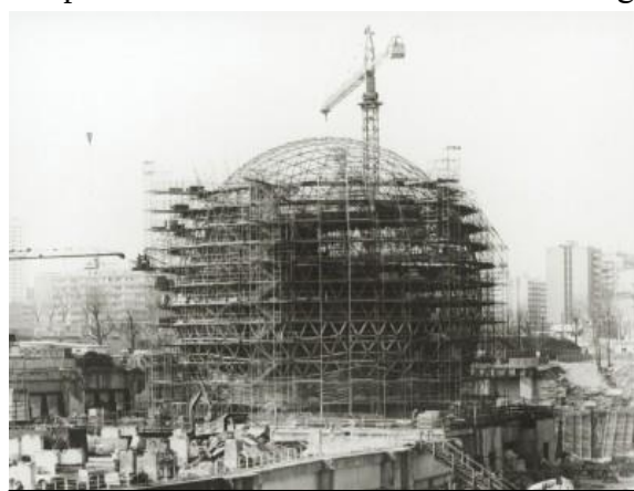
FIG 117 : Chantier de la géode
