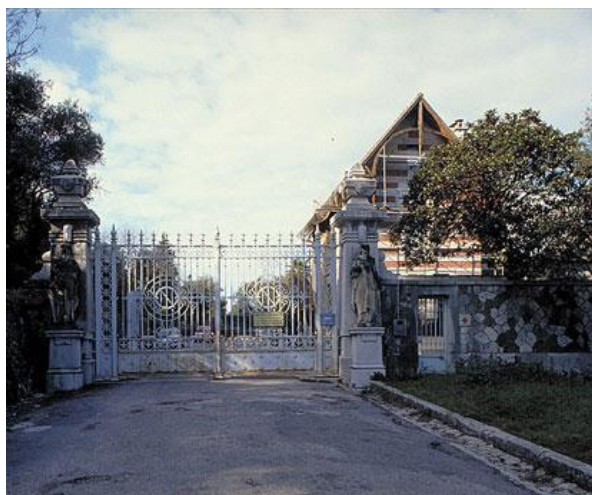
FIG 25 : Portail d'entrée monumental avec les lettres O et N entrelacées (dessiné par Garnier, réalisé par Charrol, constructeur niçois).
