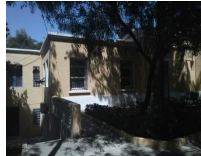
FIG 110 : Centrale de surveillance sismique
