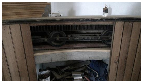
Rail de la coupole mobile reposant sur du béton. Photo prise le 25/04/2016.
