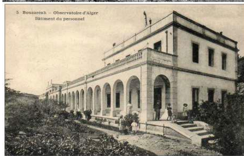
FIG 46 : Vues sur les locaux administratifs. Observatoire d'Alger.
