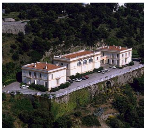
FIG 22 : Bâtiment de la Bibliothèque, après restauration. Marc Heller © Observatoire de la Côte d'Azur
