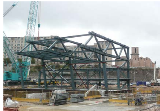
Figure 120,121 : les méga poutres utilisées au niveau de la superstructure
