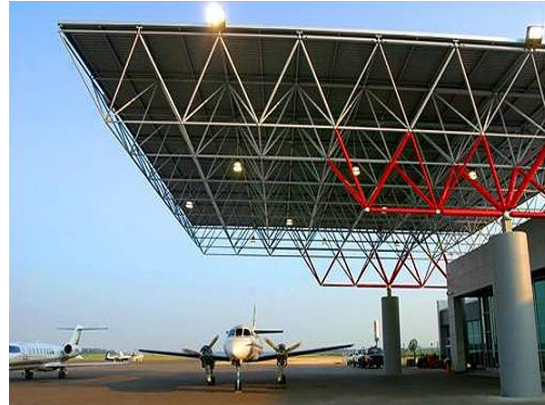
Figures 130,131 :les nœuds d'assemblage ,et les tubes en acier composant la structure.
