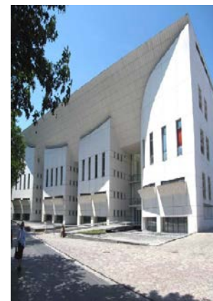
Figure 46 : toiture reliant les trois bâtiment de la cité du musique
