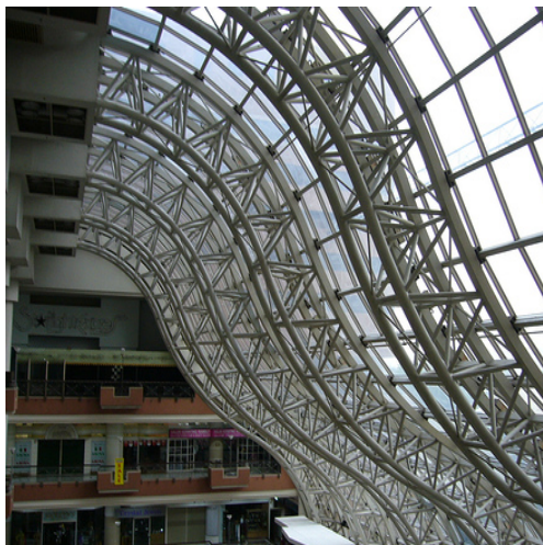
Figures123,124 :Exemples de structure tridimensionnelle
