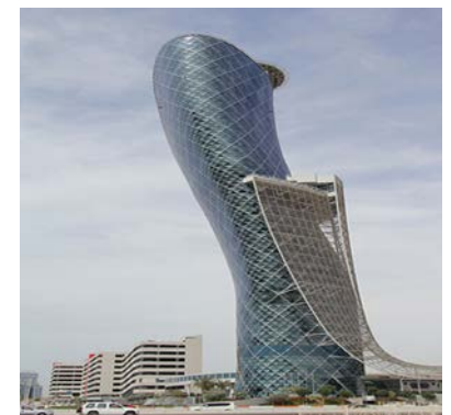
Figure 39 , La tour Capital Gate, située à Abu Dhabi, aux Émirats arabes unis
