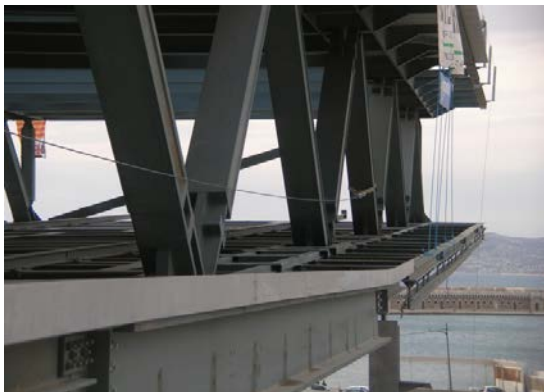
Figure 120,121 : les méga poutres utilisées au niveau de la superstructure
