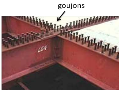
Figures 109, 110 : les différents types de connecteurs
