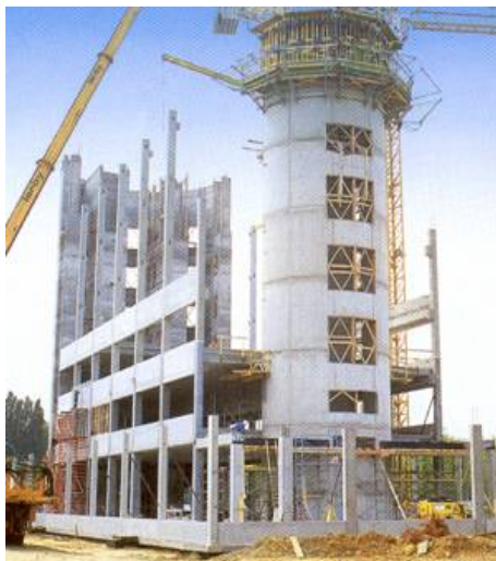
Figures 100,101: Les parois transversales sont nécessaires pour absorber la torsion occasionnée par la position excentrée du noyau
