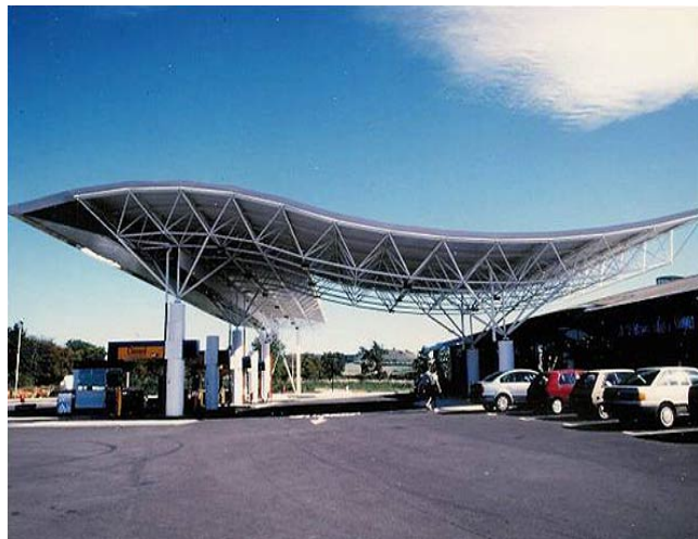
Figures123,124 :Exemples de structure tridimensionnelle
