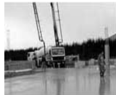
Figure 147,148,149 :la mise en œuvre sur chantier du béton
