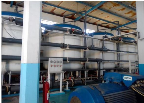
**Figure III.17 : Les filtres à sable**
