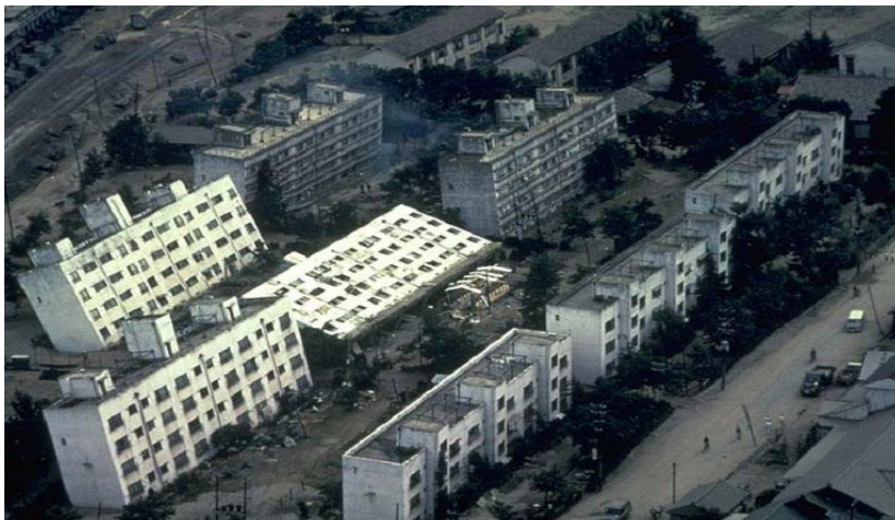
Figure 3.14 : Inclinaison des bâtiments d'appartements de Kawagishi-cho à Niigata au Japon dues à la chute de la capacité portante du sol par liquéfaction (d'après Peter M. Byrne et al, 2008)
