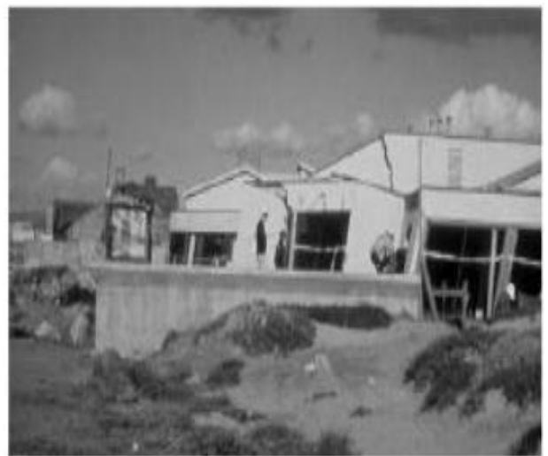
Figure 3.17: Epandage latéral le long de la route Sandholdt (à gauche) et destruction d'un centre de recherche (à droite) à Moss Landing. (D'après le Earthquake Engineering Research Center, University of California, Berkeley; Elgamal et al, 2001)
