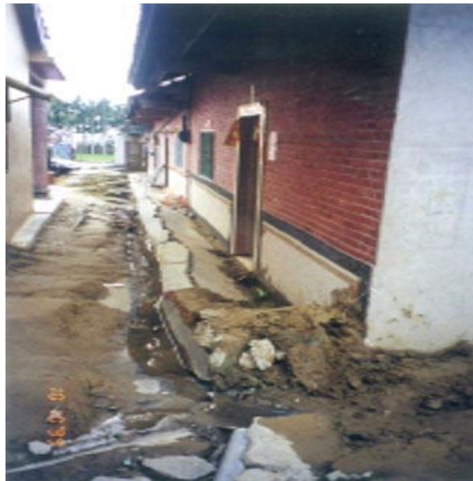
Figure 3.23 : Ebullition de sable dans un quartier résidentiel au Comté de Zhanghua (d'après Dr Hsein, 2002).
