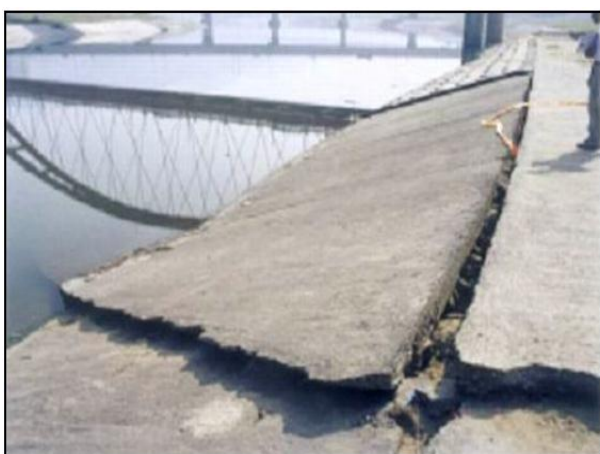
Figure 3.26 : Dommages dus à l'épandage latéral du sol en place (d'après Dr Hsein, 2002).
