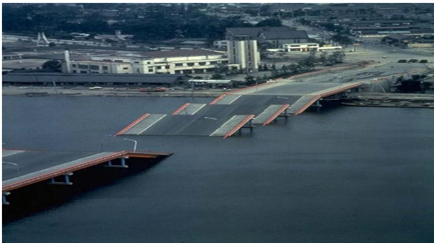
Figure 3.15 : Rupture du pont de Showa, à Niigata au Japon, dues à l'épandage latéral dans le sol (d'après PeterM. Byrne et al, 2008)
