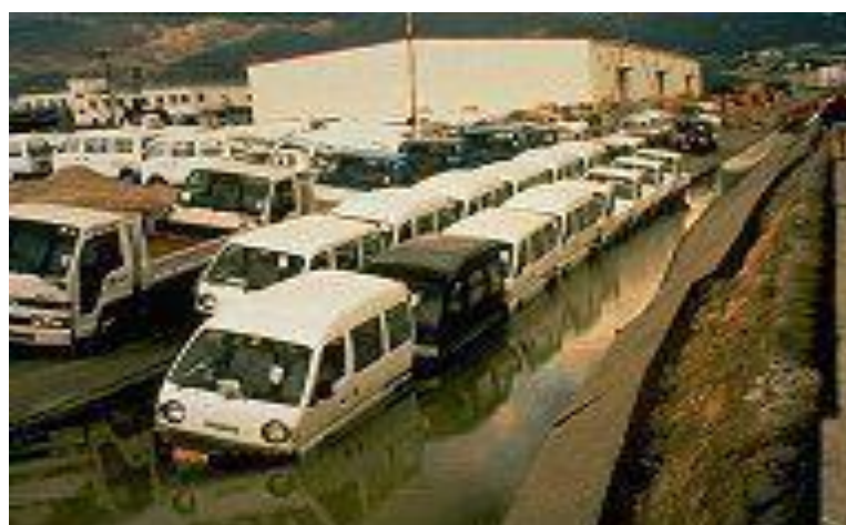
Figure 3.21 : Endommagement des routes : Baisse du niveau de la route due à l'épandage latéral (d'après Alisha Kaplan, 2004).
