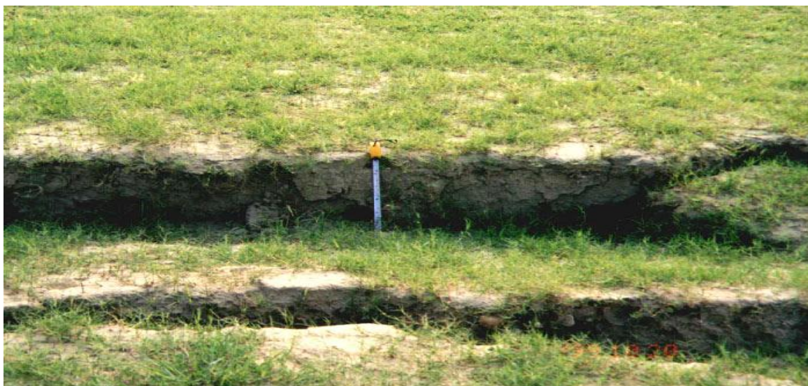
Figure 3.24 : Fissures considérables dans le sol à Nantou (d'après Dr Hsein, 2002).
