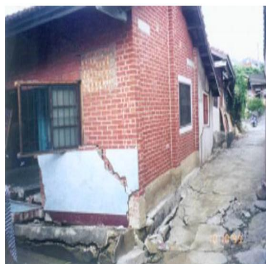
Figure 3.25 : Endommagement de bâtisses dû à la liquéfaction en Taiwan (d'après Dr Hsein, 2002).
