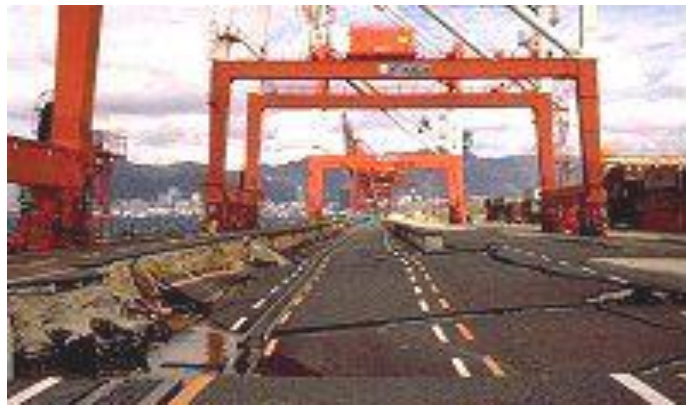
Figure 3.19 : Glissement de murs de quai : Lorsque le sol derrière et/ou sous un tel mur se liquéfie, la pression qu'il exerce sur le mur augmente considérablement et fait glisser ou/et incliner celui-ci, (d'après Alisha Kaplan, 2004).
