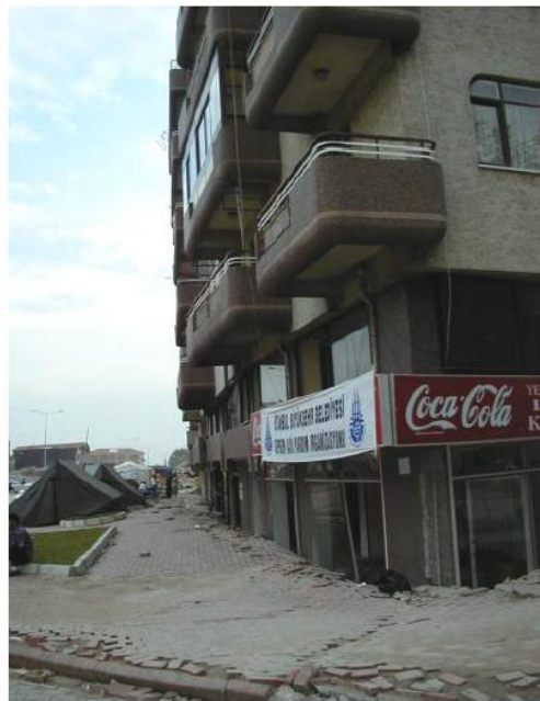
Figure 3.29 : Poinçonnement de la fondation sous la liquéfaction sisme Turquie 1999 (d'après Peter M. Byrne et al, 2008)
