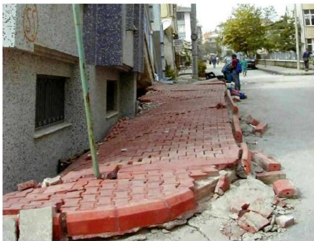
Figure 3.29 : Poinçonnement de la fondation sous la liquéfaction sisme Turquie 1999 (d'après Peter M. Byrne et al, 2008)
