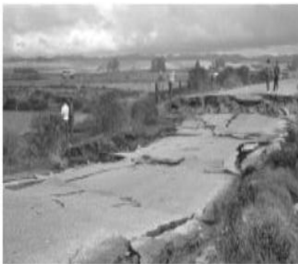
Figure 3.17: Epandage latéral le long de la route Sandholdt (à gauche) et destruction d'un centre de recherche (à droite) à Moss Landing. (D'après le Earthquake Engineering Research Center, University of California, Berkeley; Elgamal et al, 2001)
