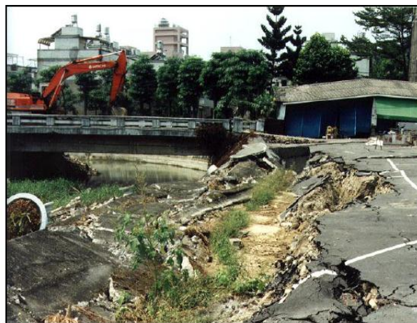
Figure 3.26 : Dommages dus à l'épandage latéral du sol en place (d'après Dr Hsein, 2002).
