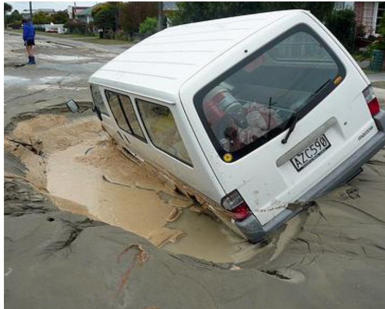
Figure 3.34 : Une camionnette qui malheureusement conduit dans un trou causé par la liquéfaction, du Nord de New Brighton, lors du séisme de Christchurch (2011)
