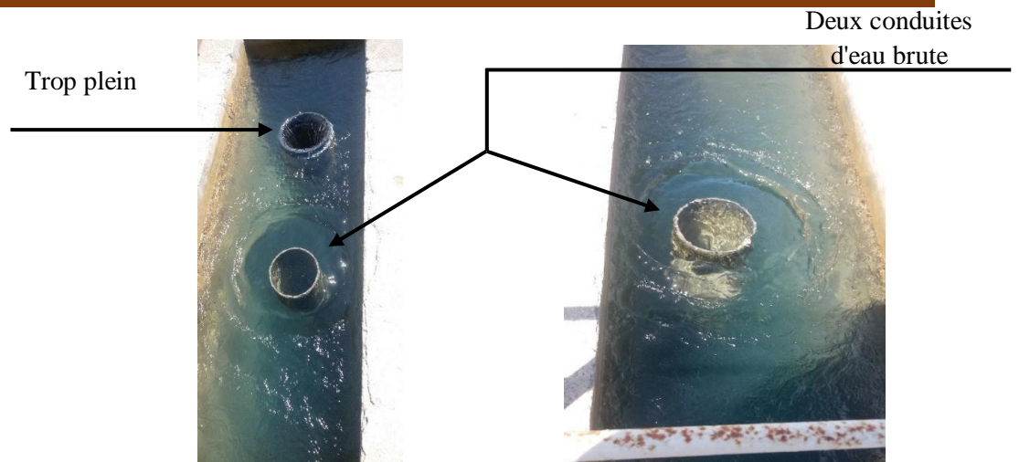
Figure III.4 :1 er compartiments l'arrivée d'eau.
