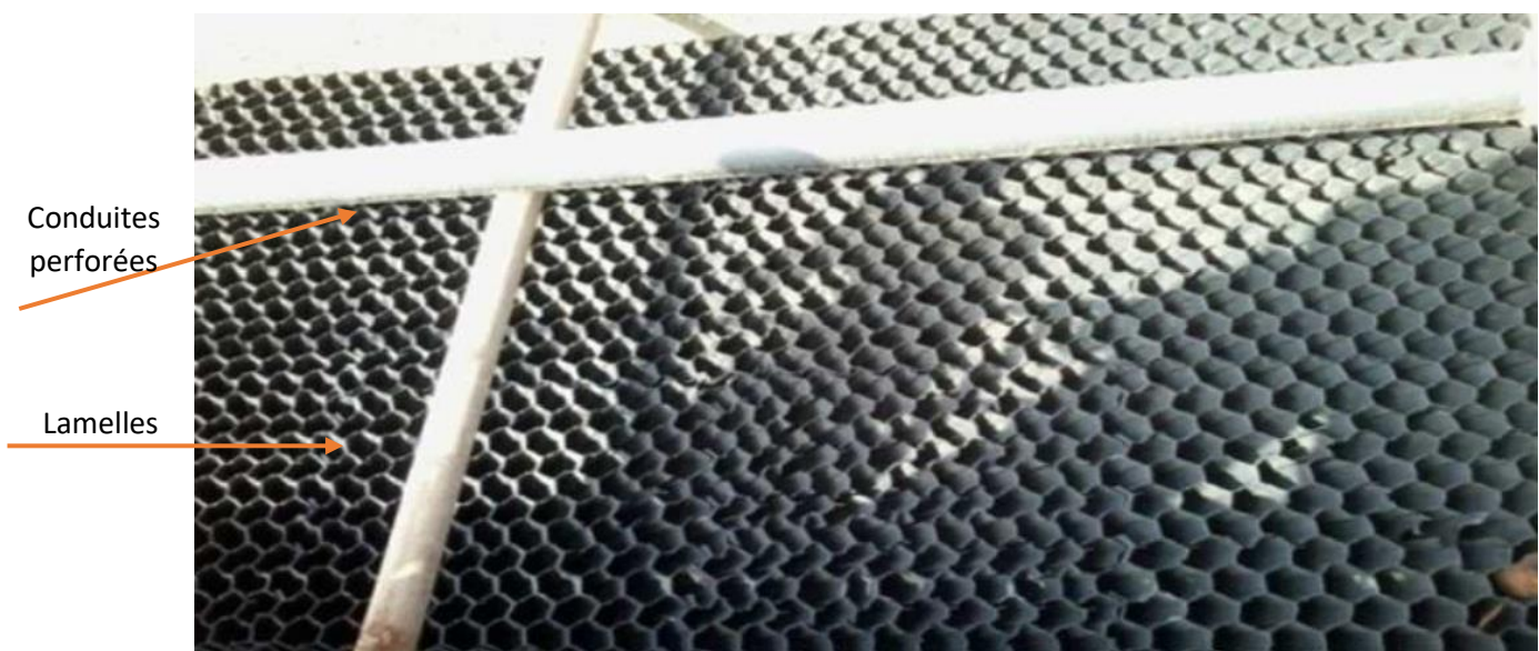
Figure III.5 : Décanteur lamellaire.
