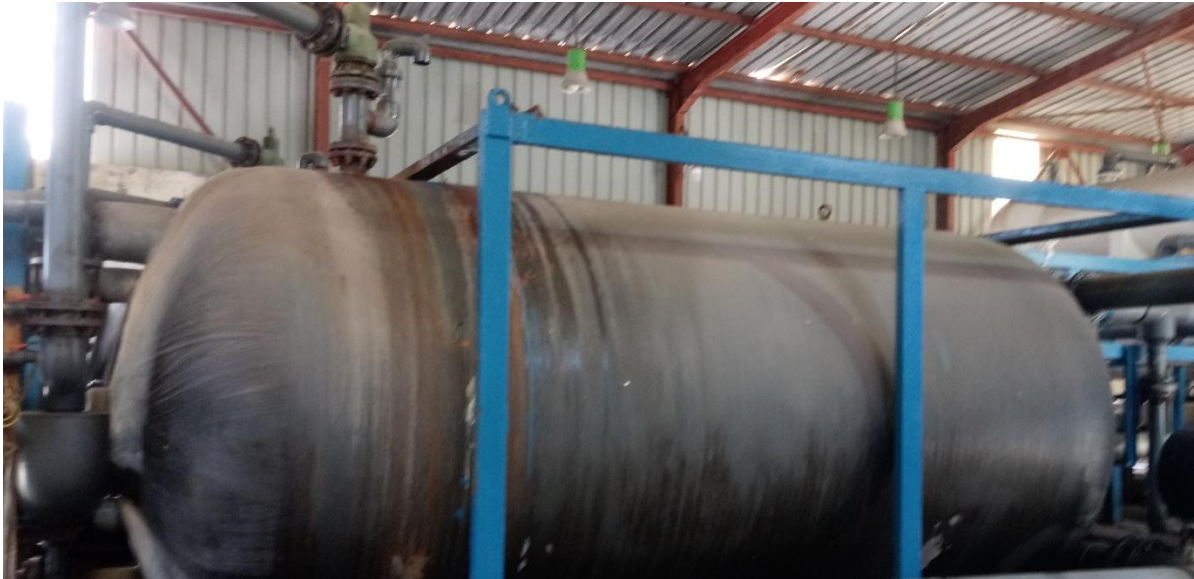
Figure III.9 : Filtre à sable.
