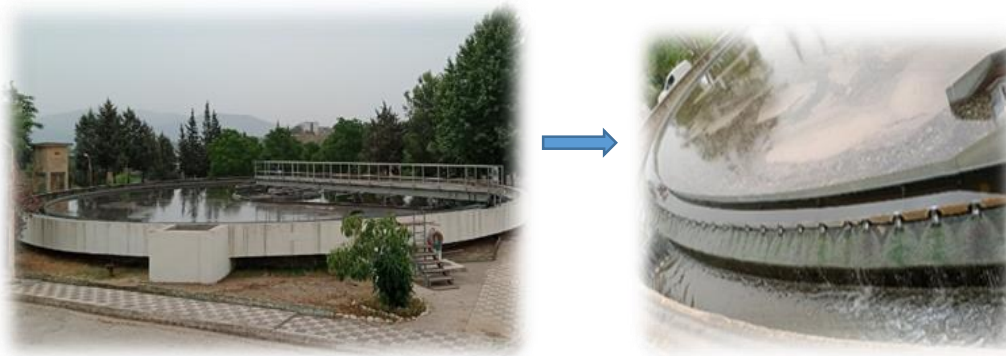
Figure 25 : Clarificateur
