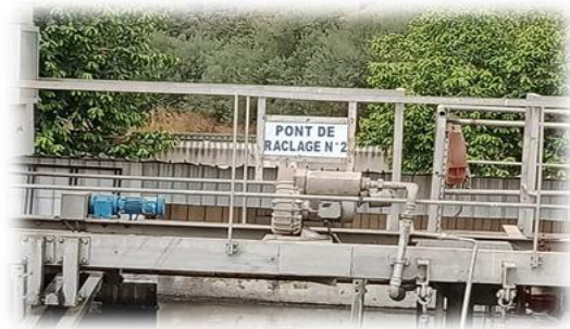
Figure 22 : Ponts de raclages
