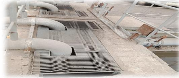
Figure 27 : Poste de recirculation des boues
