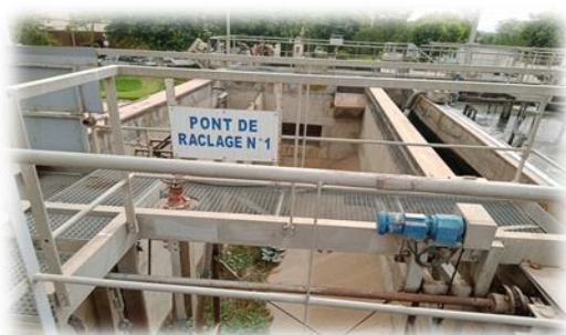
Figure 22 : Ponts de raclages
