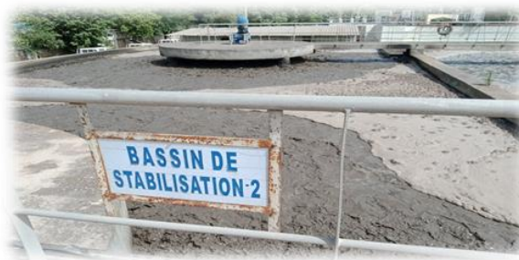
Figure 28 : Bassin de stabilisation
