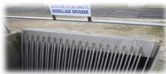
Figure 16 : Dégrilleur grossier
