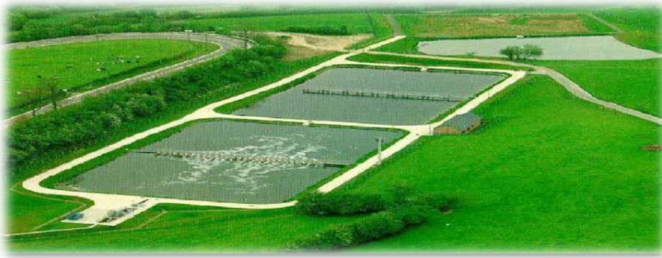
Figure 13 : Lagunage aéré (BENFIALA et HAOULI, 2017).
