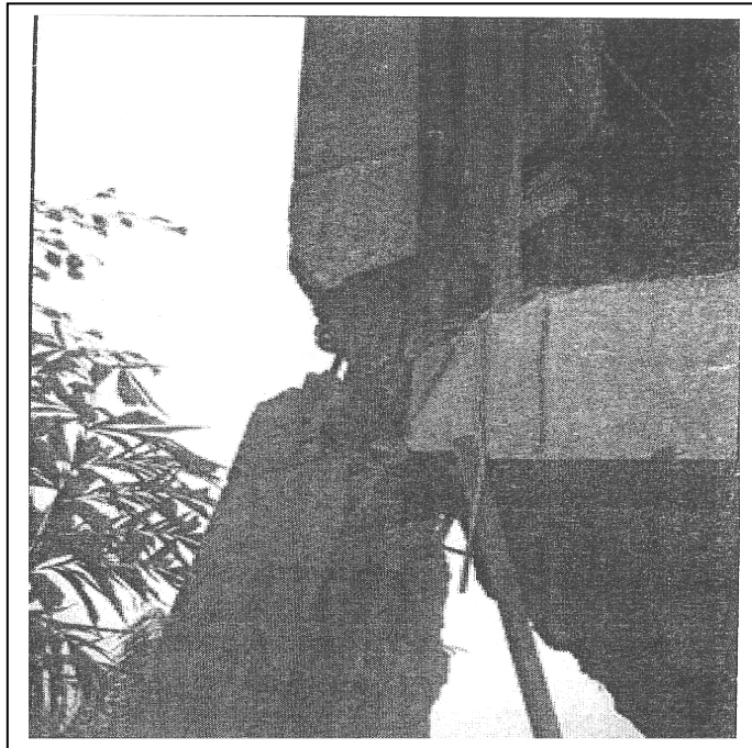
(Figure(III.7) : Liaison non-dissipative poteau-poutre en béton armé.
