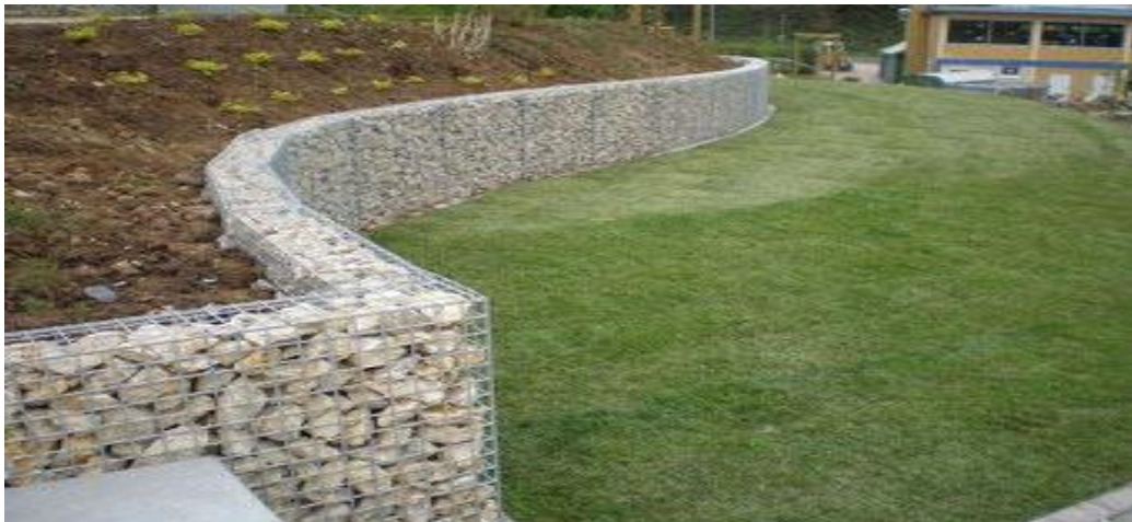
Figure 1-3 : exemple d'un gabion
