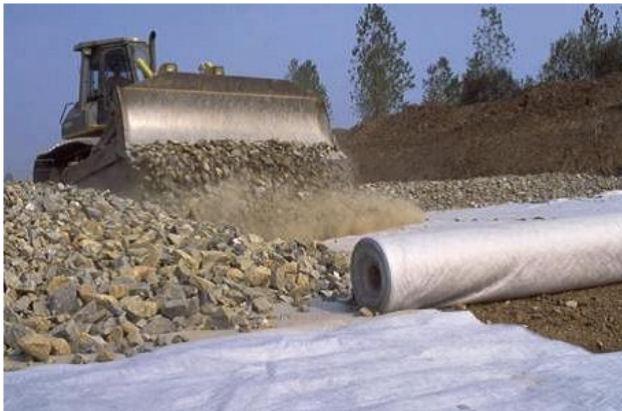
Figure 1-7 : séparation de route, voies ferrées, piste ferroviaire
