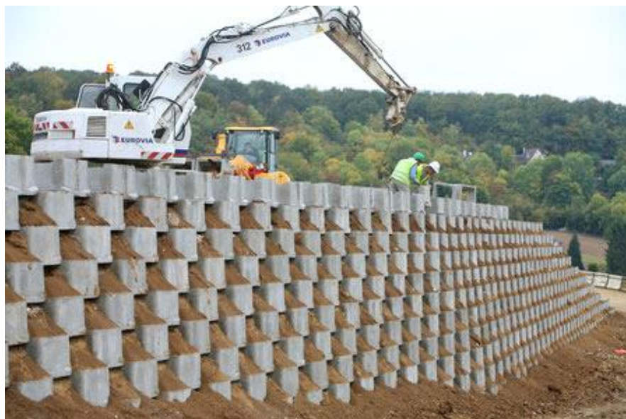
Figure 1-2 ; le caisson végétal sable
