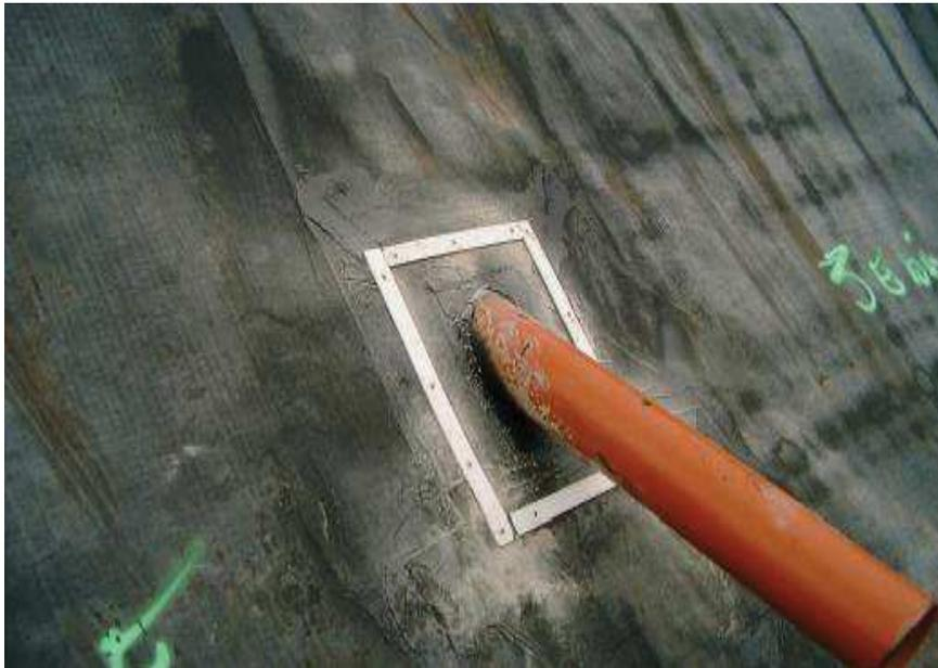
**Figure II-6:** Géomembrane bitumineuse soudée ou raccordée
