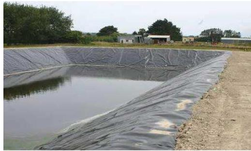
Figure II-5 : Bassin étanchié par une géomembrane EPDM
