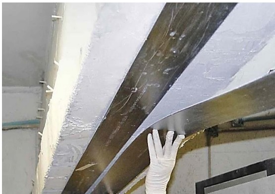
Figure I.11: Renforcement par plats partiellement et entièrement insérés [36].
