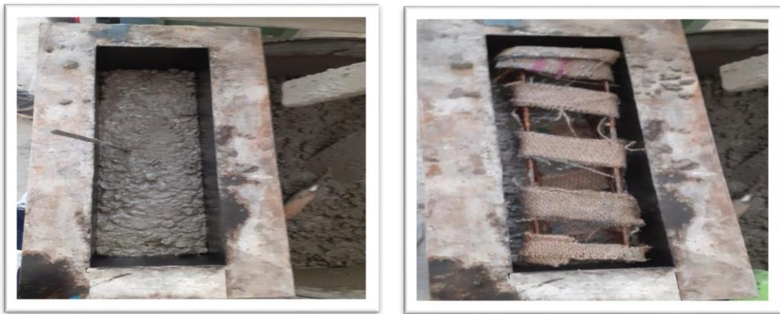
Figure II. 3: Coulage du béton dans les moules.
