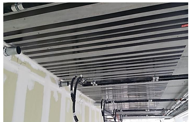
Figure I.11: Renforcement par plats partiellement et entièrement insérés [36].
