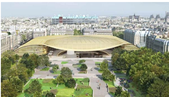
Fig.85. Vue d'ensemble sur la Canopée
