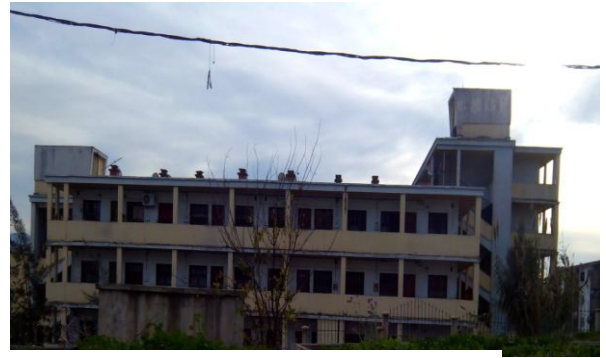
Fig.126. Façade actuelle du bâtiment
