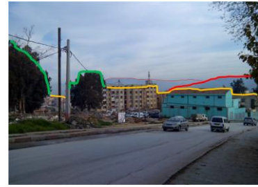
Fig.33. Vue depuis site côté Sud
