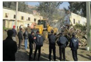
En novembre 2014, opération de démolition et de relogement des habitants à oued falli.
