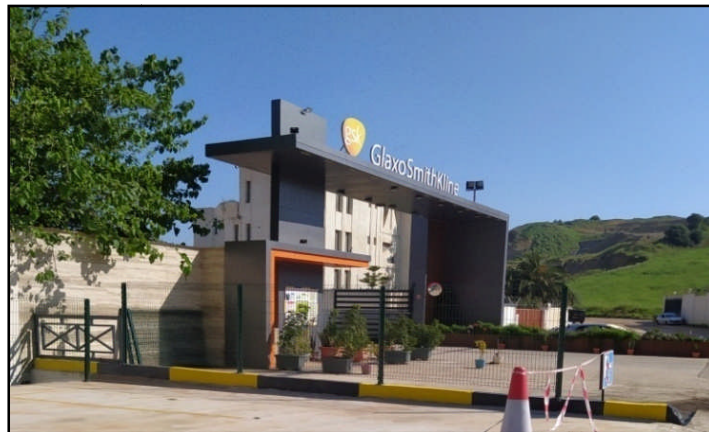
Figure 07 : Unité de production pharmaceutique GSK - Boumerdès.
