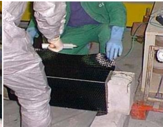
6. Marouflage : dégagement des bulles d'air avec un rouleau
