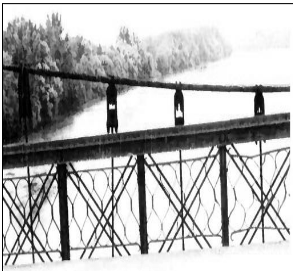
a) inclinaison d'une suspente
