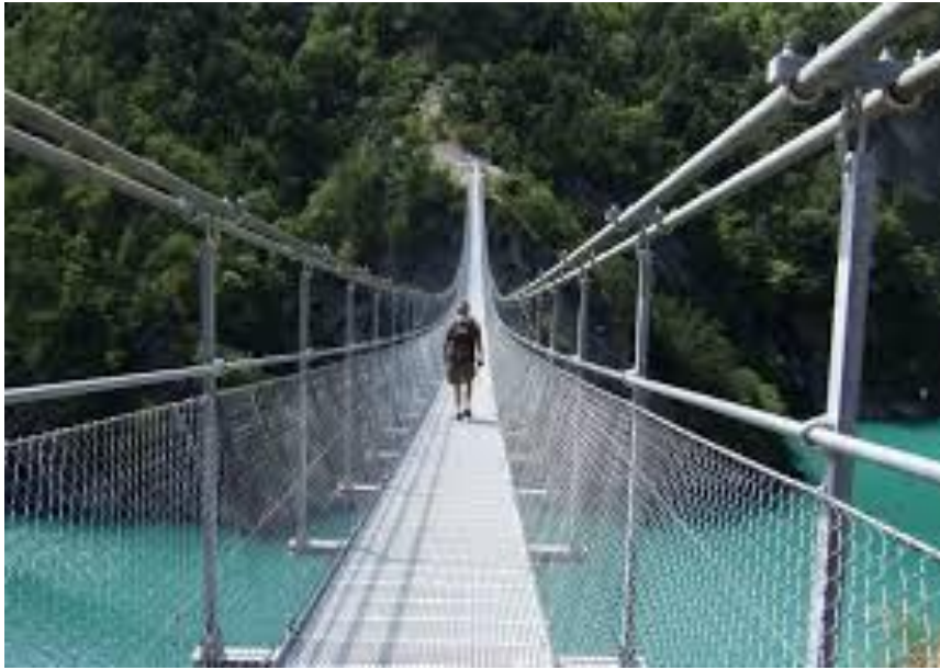
Figure 1-4: Passerelle piétonnière suspendue rigidifiée par des câbles précontraints
