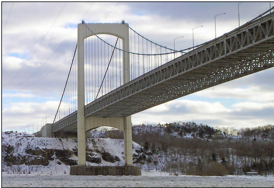
Figure 2-2: Pont routier Pierre-Laporte, Québec city, à trois travées et long de 1041 m (travée principale : 668 m, hauteur : 116 m)
