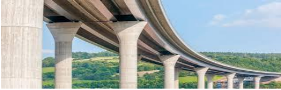
Figure I.3. Pont à poutre en béton précontraint.
