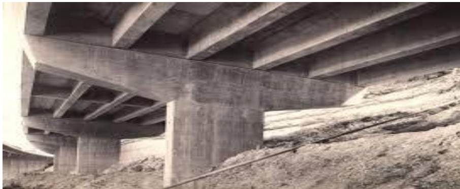
Figure I.2. Pont à poutre en béton armée.
