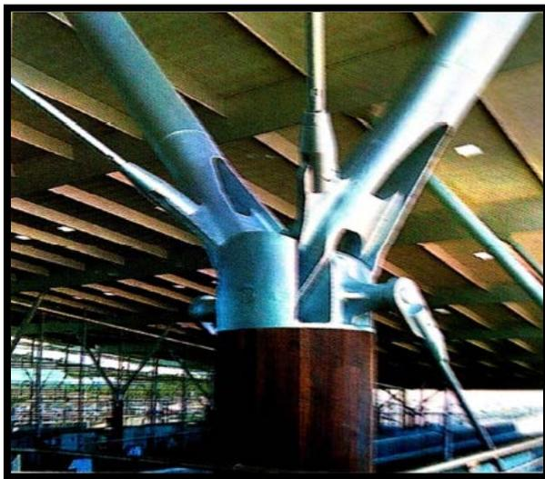
Figure 86 :Pièce moulée pour les poteaux d'une gare TGV
