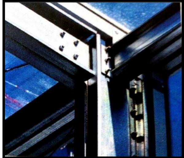
Figure 87:Structure en profils minces boulonnées
