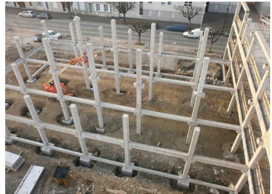
Figure 109: Structure Mixte de la partie centrale
