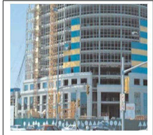
Figure 114: Système de mur-rideau à ossature, Bureau de poste a Ottawa
