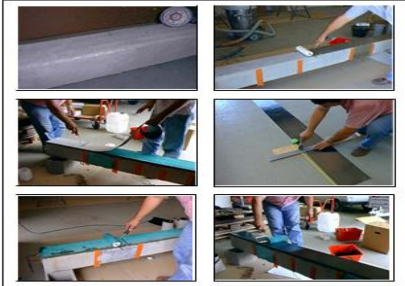
Figure II.18. Mise en œuvre par stratification directe. [26]
