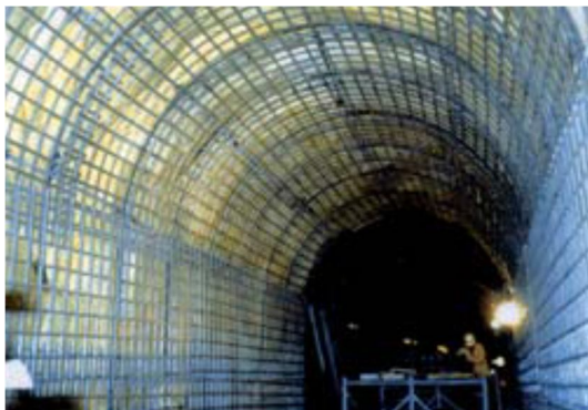
Figure II.22: Armatures composites pour le renforcement des ouvrages en béton.
