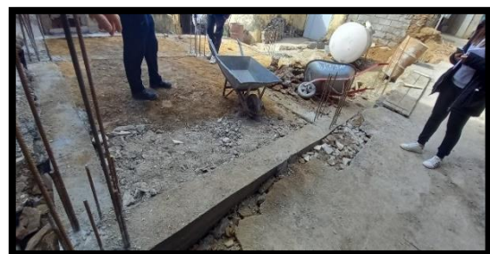
Figure41 : Démolition totale de la maison DAHONA a Ath larabaa Beni yeni (Source l'auteur)
