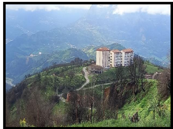
Figure 43 : Logements AADL à Ath lahcen Tizi-Ouzou Source : auteur
