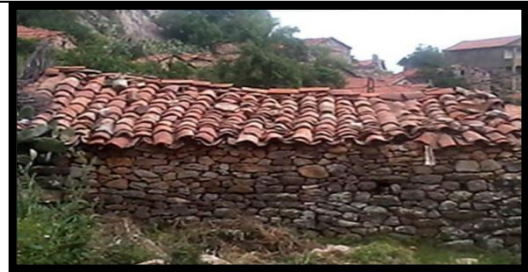
Figure 37 : Charpente de maison du village Boumensour
