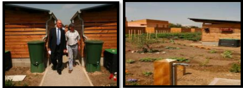
Figure 79 : démontrant les systèmes de récupération des eaux pluviales Source : www.ecoquartier.logement.gouv.fr
