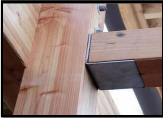
Figure134 : Assemblage poteau-traverse. Source : www.constructionbois.bilp.fr .
