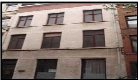
Figure 92 : Façade avant le projet
