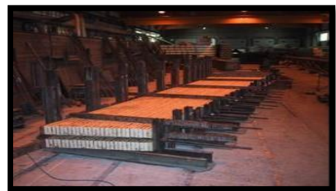
Figure 126: Aboutage et pressage des pièces de bois.
