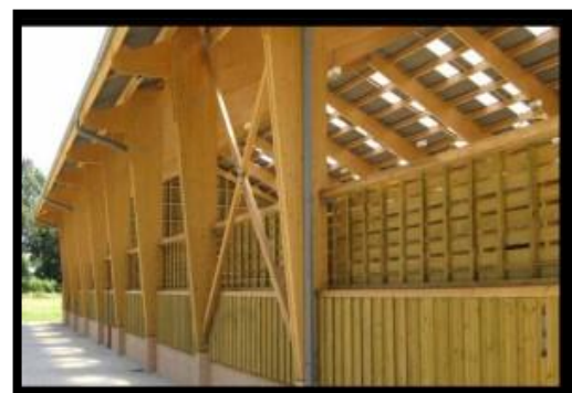
Figure 128: construction en bois lamellé collé.
