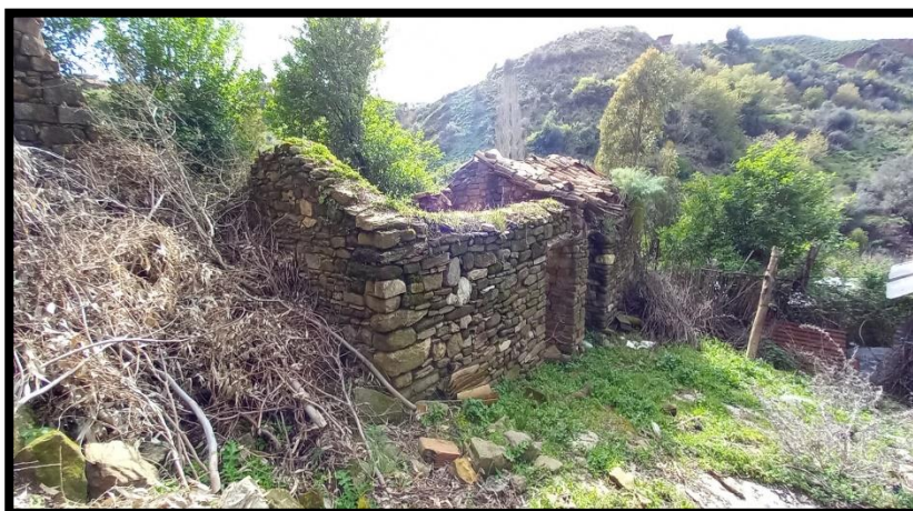
Figure 24 : une ancienne maison kabyle
