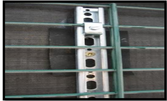
Fixation de la structure primaire au-dessus du pare-pluie
