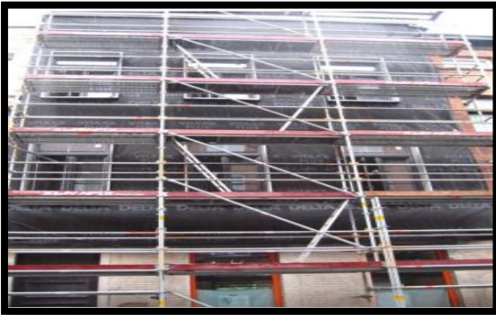
Pose de l'isolant et du pare-pluie
