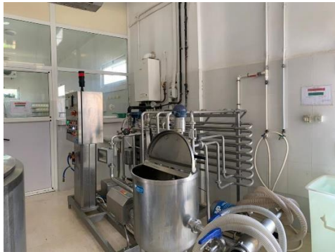
SALLE DE PASTEURISATION
