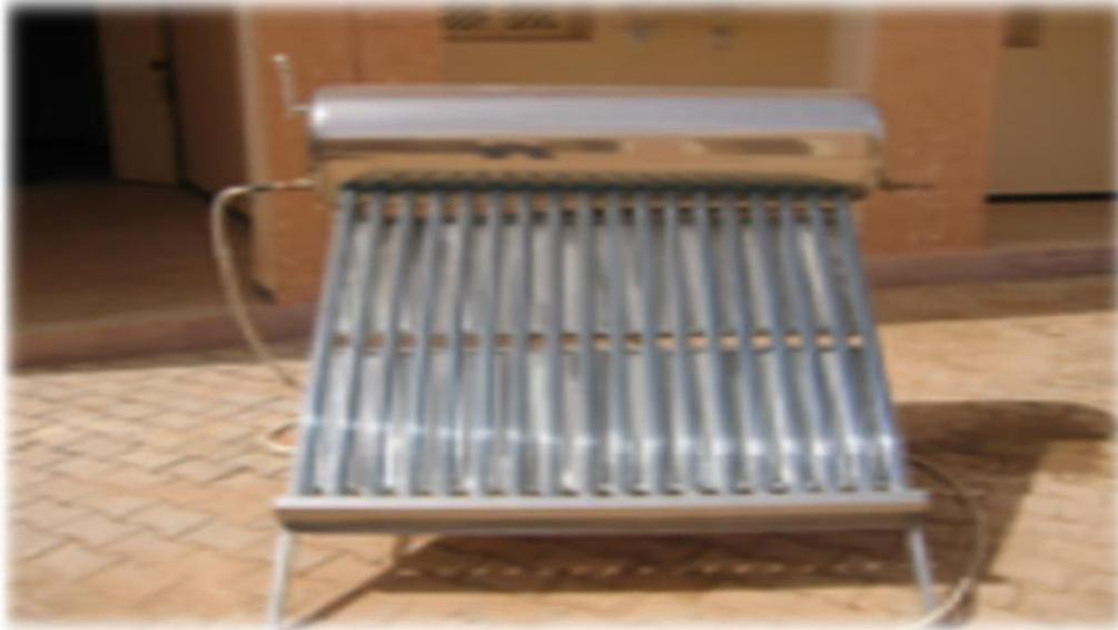
**Figure I.21 :** Capteurs à tubes sous vides.
