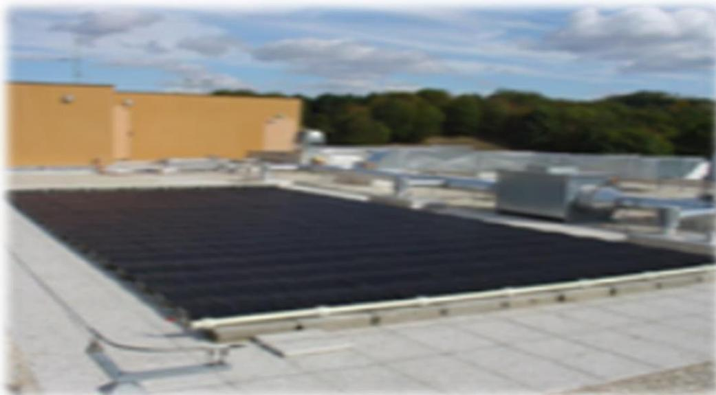
**Figure I.22 :** Capteurs sans vitrage
