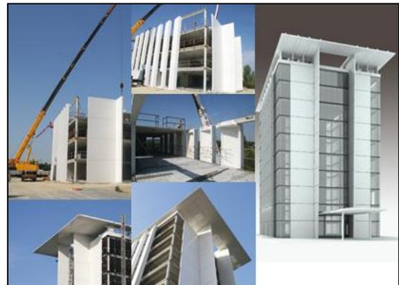
Figure 145: panneaux préfabriqués en béton
