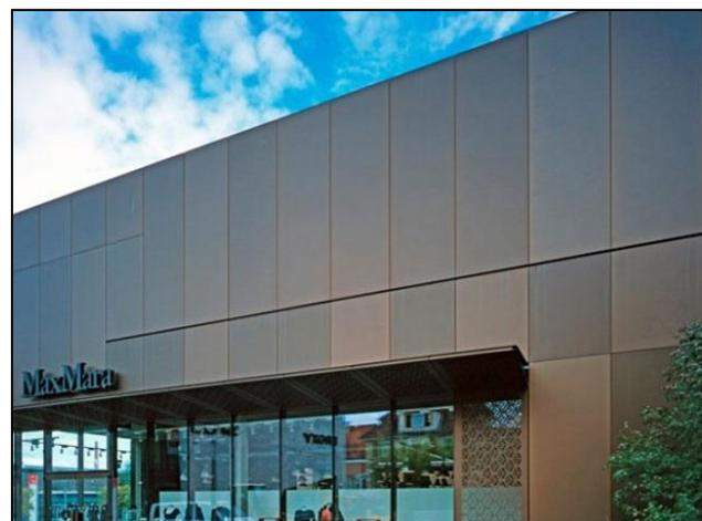
Figure 142: revêtement de façade en plaque d'aluminium
