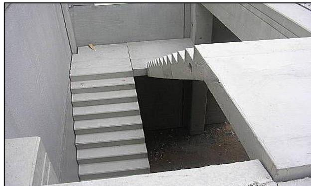
Figure 6: Escalier béton
