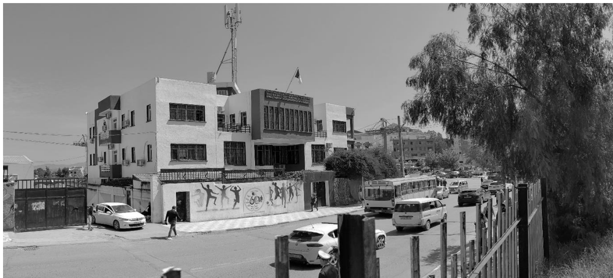
Figure 93 : Nœuds du Stade avant intervention Source : Auteurs
