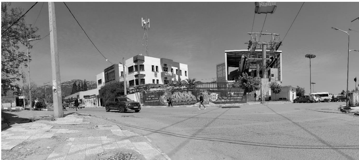
Figure 91: Nœuds du Stade avant intervention Source : Auteurs
