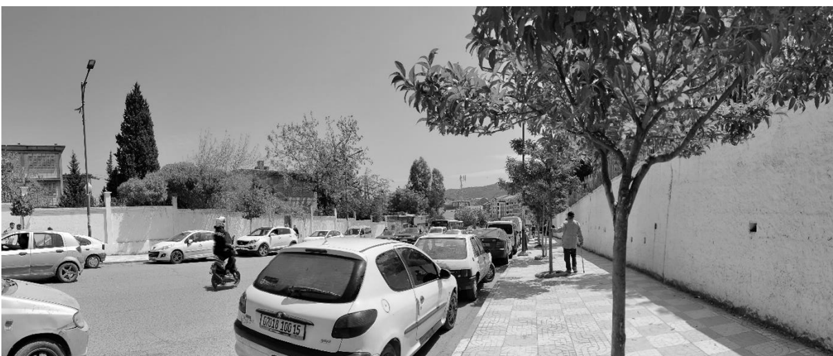
Figure 111: Rue Lamali Ahmed aux parois aveugles Source : Auteurs
