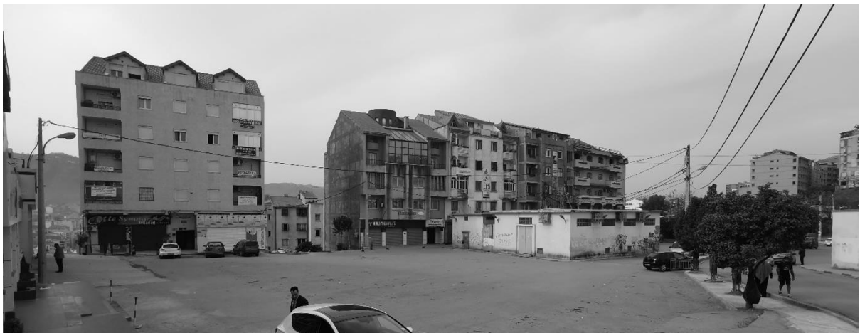
Figure 97: Parcelle du Lotissement Thala avant intervention Source: Auteurs
