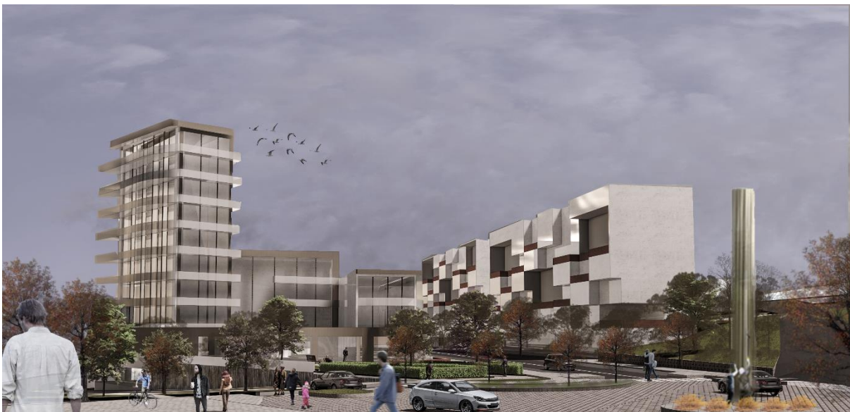
Figure 89 : Nœuds des Bâtiments bleu après intervention
