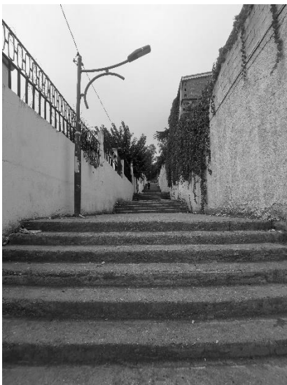
Figure 119: Escalier urbain avant intervention Source : Auteurs
