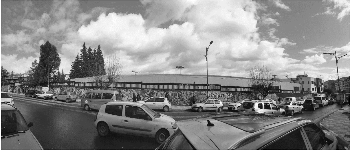
Figure 95 : Stade 1er Novembre avant intervention Source : Auteurs
