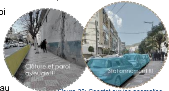
Figure 38: Constat sur les anomalies Source : Auteurs
