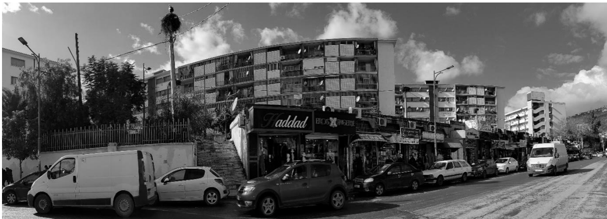
Figure 122: La cité des genets avant intervention Source : Auteurs
