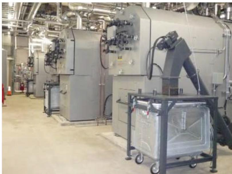
**Figure I.2 :** Quatre chaudières à bois assurent le chauffage de locaux et d'ECS à distance
