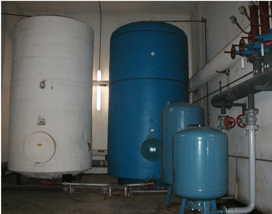
**Figure I.13** : deux grands ballons d'eau chaude avec deux vases d'expansions.
