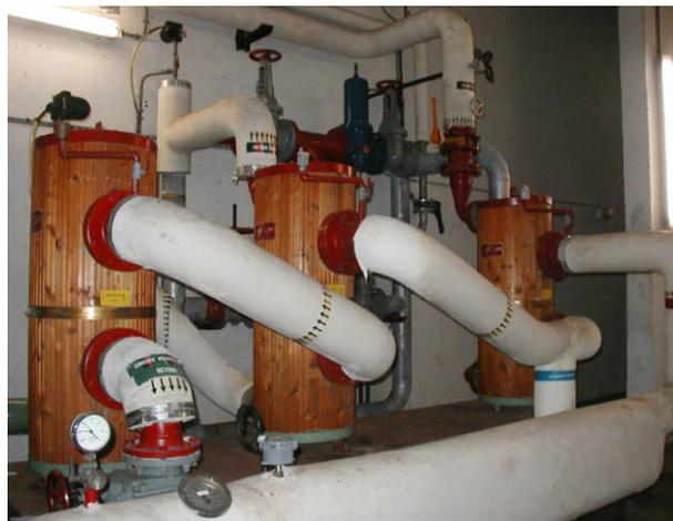
**Figure I.12:** Trois échangeurs tubulaires montés en série [18].
