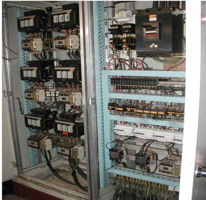
**Figure I.20 :** Armoire de commande électrique.
