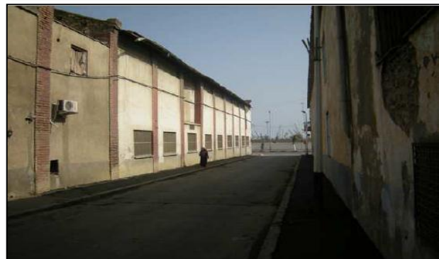
Figure 52 : vue sur les rues secondaires du quartier du HAMMA (source : auteur)
