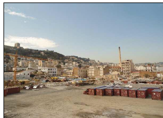
Figure 67 : hangars et habitat en état de vétusté (Source : auteur)
