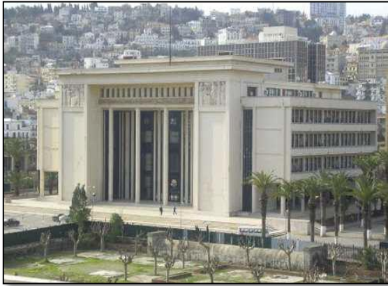
Figure 64 : Bâtiment type Moderne - Siège UGTA (source : auteur)
