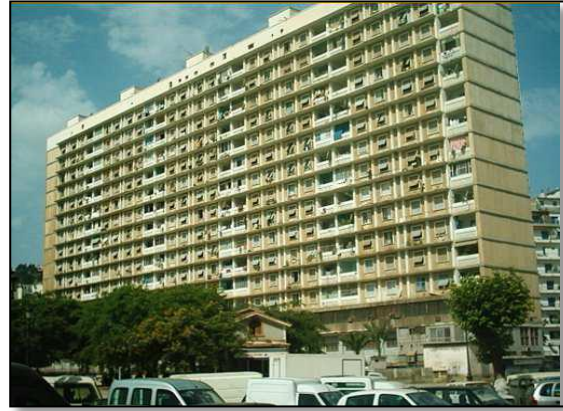
Figure 65 : Bâtiment type H.B.M (source : auteur)
