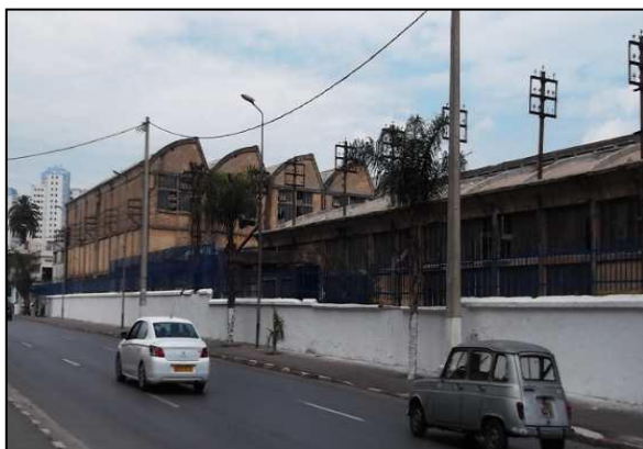
Figure 66 : hangars et habitat en état de vétusté (Source : auteur)
