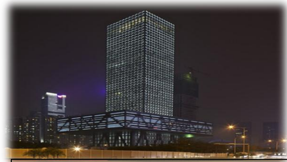
Fig.81 Les façades de la bourse Shenzhen Source: www.Google image.fr
