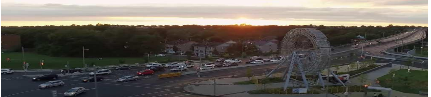
Figure 84 : l'échangeur et la voie après l'intervention
