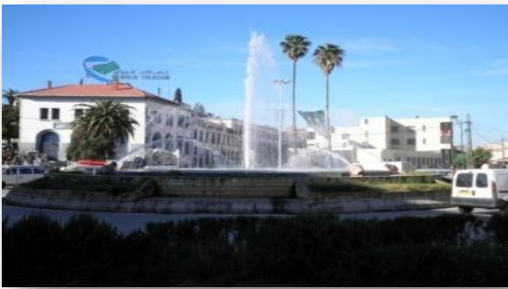
Figure 94: Nœud de Babouche said avant l'intervention
