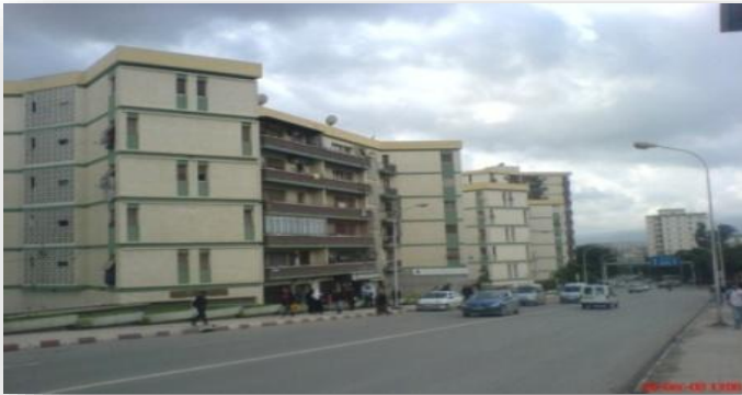
Figure 102 : cité 20 aout avant l’intervention
