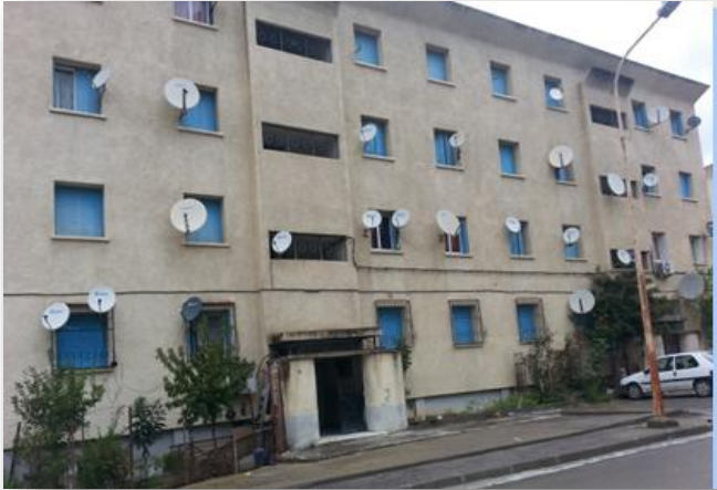
Figure 104 : cité 11 décembre avant l'intervention
