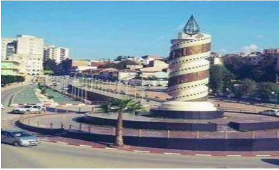
Figure 92: Nœud de Bougie avant l'intervention
