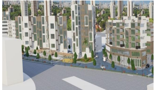
Figure 103 : cité 20 aout après l’intervention
