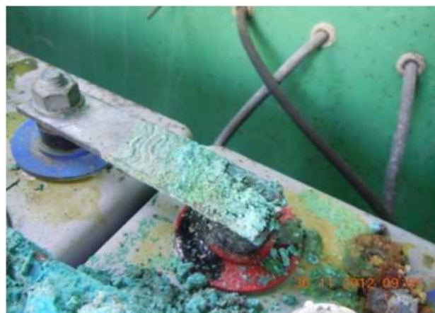
Figure I.18 : Phénomène de la sulfatation
