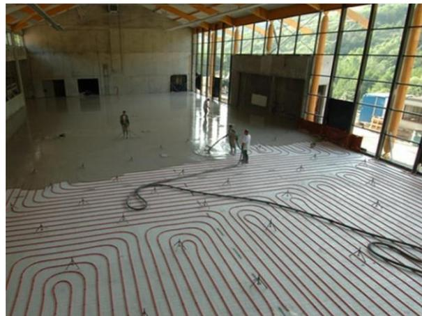
Figure 179 : réalisation plancher chauffant,
