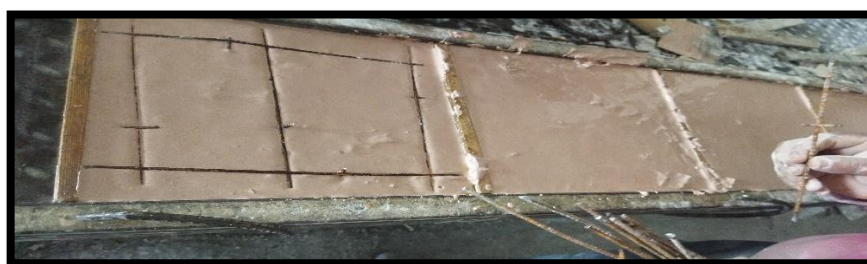
Figure 34: L'utilisation de la ferraille pour objectif de donner une certaine résistance.
