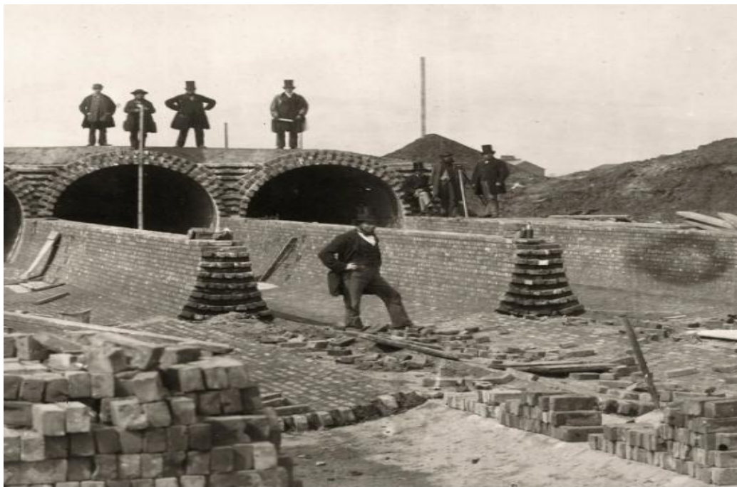
Figure 1.7 : Construction du réseau d'égout (Halliday, 1999).
