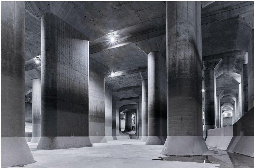
Figure 1.10 : intérieur du Metropolitan Area Outer Underground Discharge Channel (aussi appelé G-Cans)
