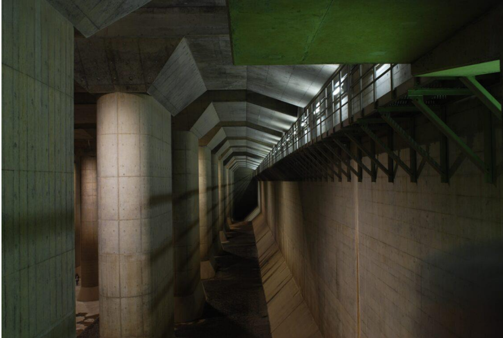
Figure 1.9: Vue d'ensemble de la structure G-Cans (Wikipedia)
