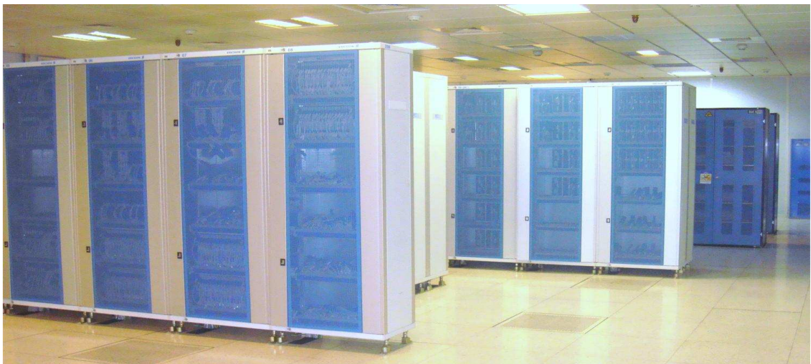
Figure II.1 : Un commutateur temporel AXE10.
