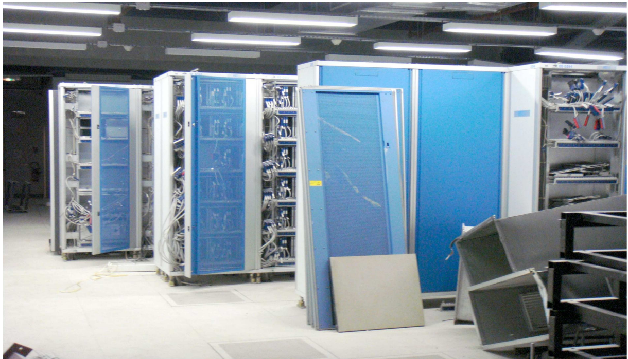
Figure III.2 : unité d'abonnés éloignés RSS au cours du montage en 2013.
