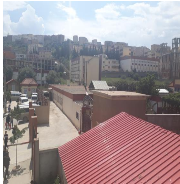
Figure119:lycéeTaousAmrouche, source: photo prise par les auteurs
