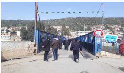
Figure 18 : le pont piéton. Source : photo prise par auteurs
