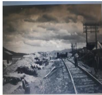
Figure 34 : Chemin de fer. Source : www.alger-roi/roi sidi aich
