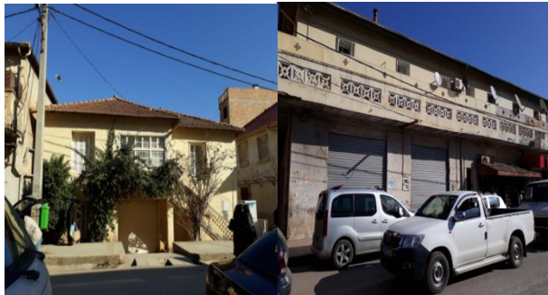
Figure 58 : Construction R+1 Source : photos prise par l'auteur
