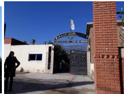
Figure 47: Lycée Taous Amrouche. Source : photos prise par l'auteur.
