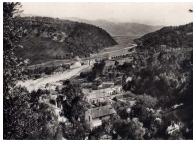
Figure 27: Sidi aich vue générale. source : www.alger-roi/roi sidi aich
