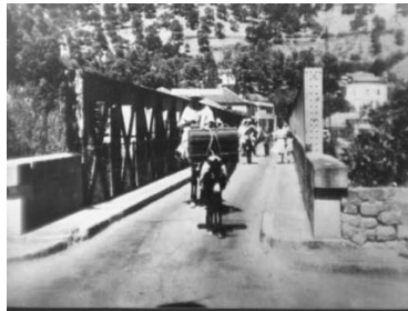
Figure 28 : premier pont de la ville de Sidi aich.
