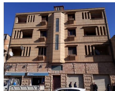
Figure 60 : nouvelle construction en R+3 Source : photos prise par les auteurs
