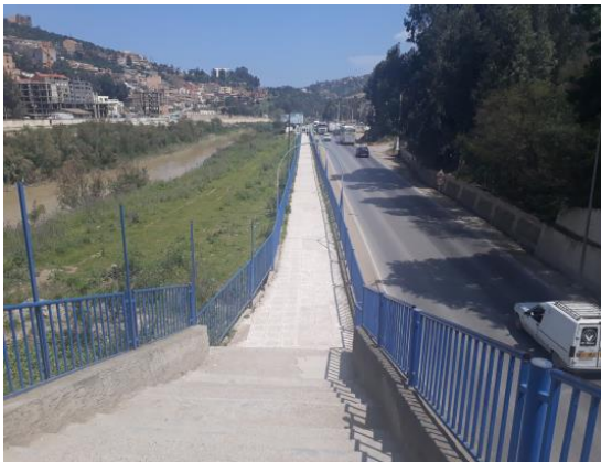
Figure136: la voie de dédoublement Source: photo prise par les auteurs
