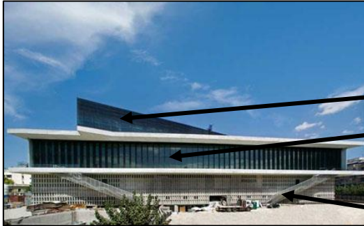
Figure 94 : Vue sur la façade du musée de l'acropole Source: www.geneveactive.ch
