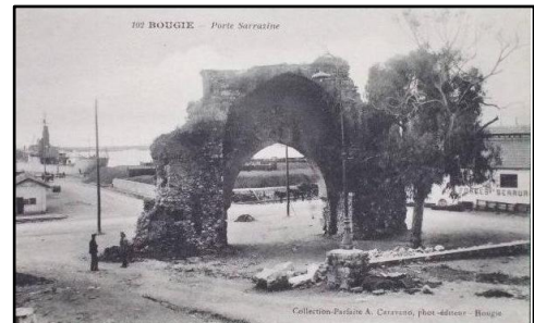
Figure 43 : les changements apportés à la porte à l'époque coloniale.
