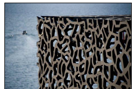
Figure 88 : Paroi perforée du MuCEM Source : Marc Roudier
