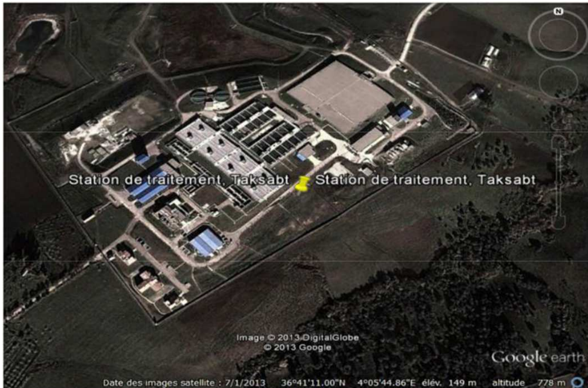
Figure 2 : La localisation géographique de la station de traitement de TAKSEBT
