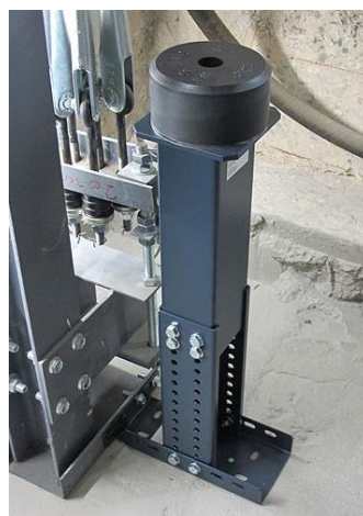
Figure II.22: Montage d'un amortisseur.
