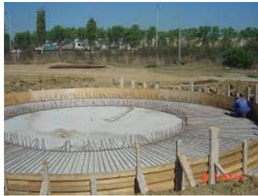
Figure 1.10. Fondation d'un réservoir métallique
