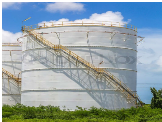
Figure 1.9. Ceinture de renforcement
