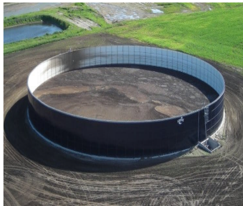
Figure 1.12. Réservoir a cuve ouverte
