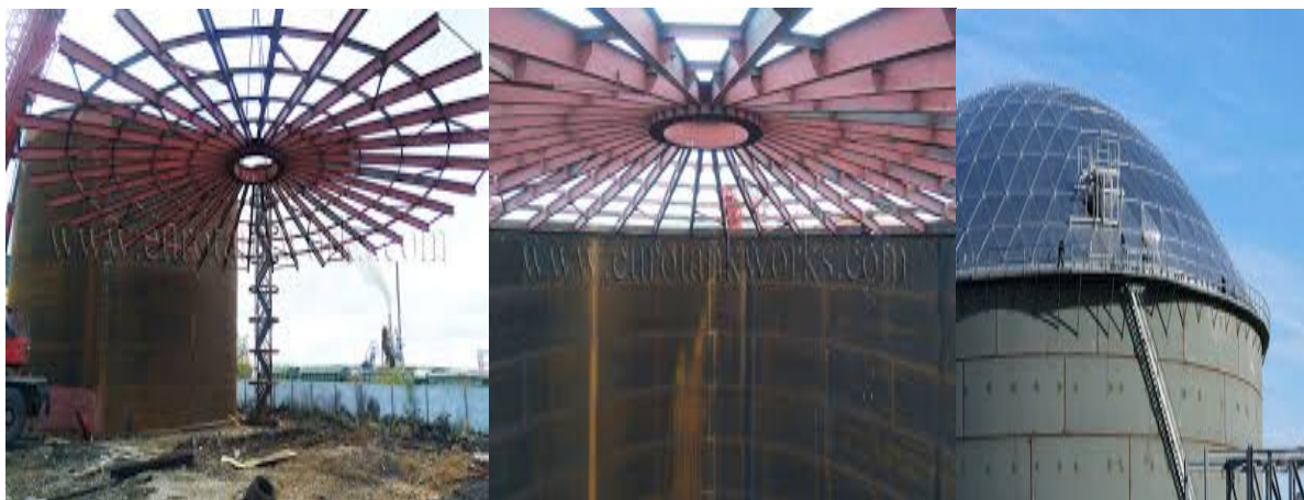
Figure 1.14. Réservoir à toit fixe
