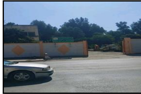
Figure 47 : unité des travaux publics. Source : Auteurs, octobre 2023
