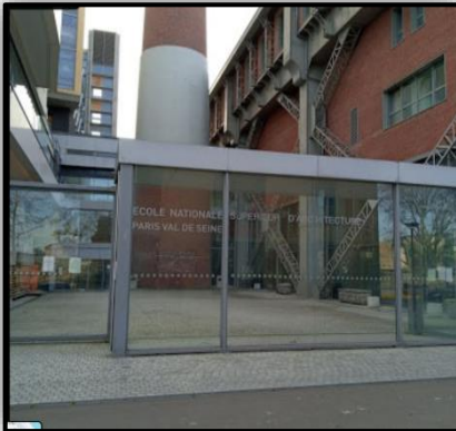
Figure 173 : vue sur l'entrée de l'école. Source : https://frederic-borel-
