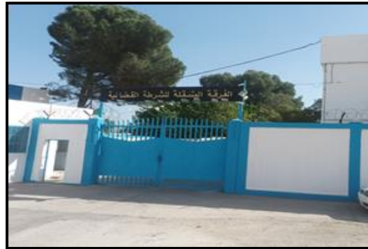
Figure 111 : vue sur l'unité de police. Source : Auteurs
