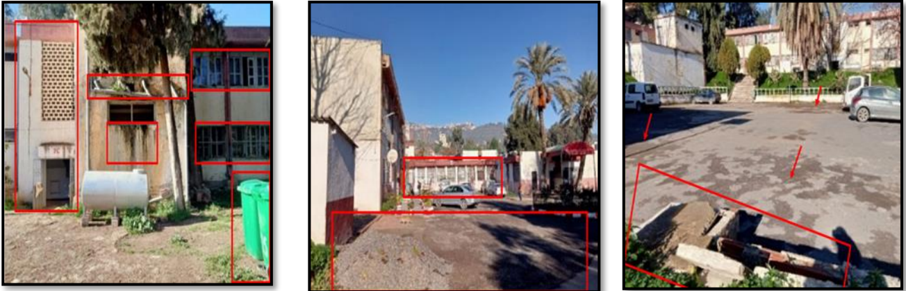
Figure 63 : photos représentatives la résidence universitaire. Source : Auteurs, octobre 2023
