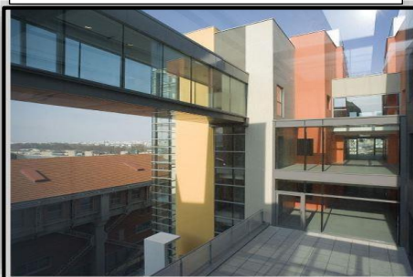
Figure 176 : vue sur la passerelle. Source : https://frederic-borel-
