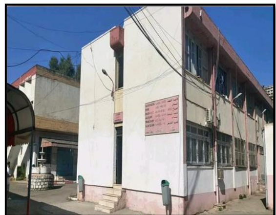
Figure 62 : Administration de la résidence Source : Auteurs, octobre 2023
