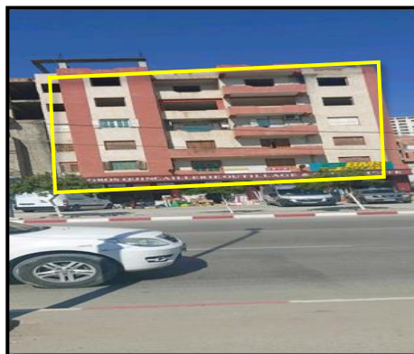
Figure 101 : vue sur l'immeuble mixte source : Auteurs.
