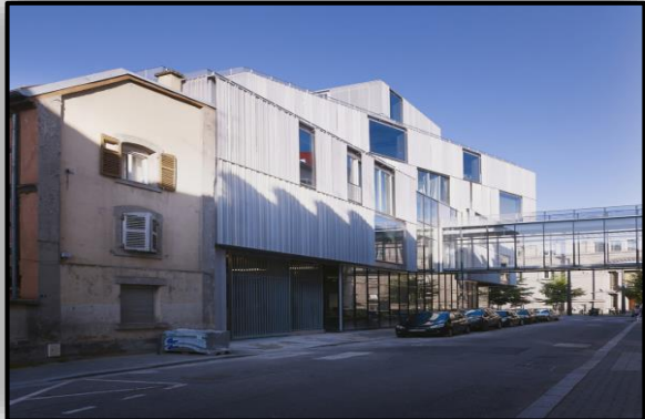
Figure 150 : vue sur la passerelle. Source : www.archdaily.com
