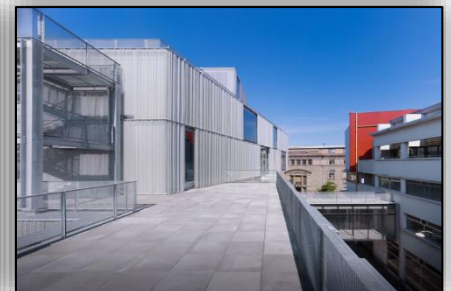
Figure 164 : vue sur la passerelle. Source : www.archdaily.com
