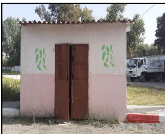
Figure 61 : Locaux Techniques. Source : Auteurs, octobre 2023
