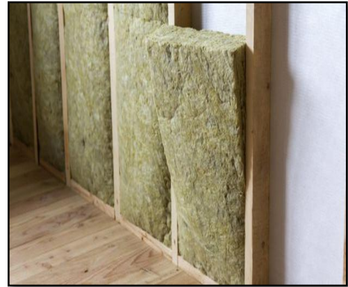
Figure 200 : Fixation des panneaux de laine de roche.
