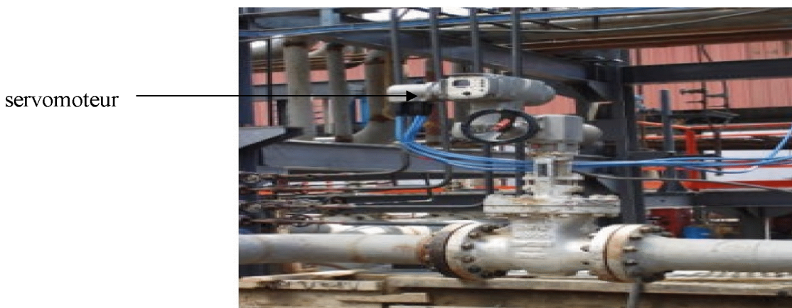
Figure II.3. : Servomoteur électrique monté sur une vanne dans une centrale électrique
