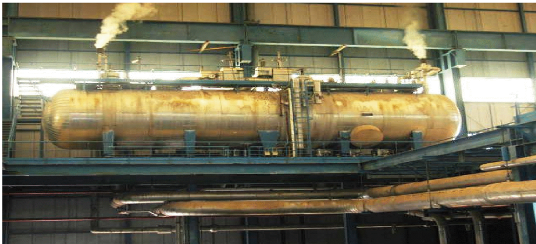
Figure I.7 : Vue de face de la bâche alimentaire.
