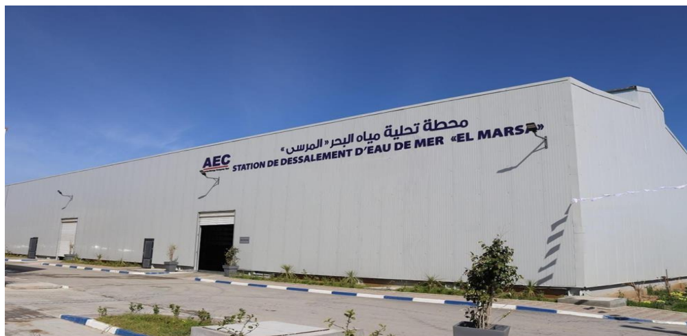
Figure II.2 : La station de dessalement de l'eau de mer El Marsa [39].
