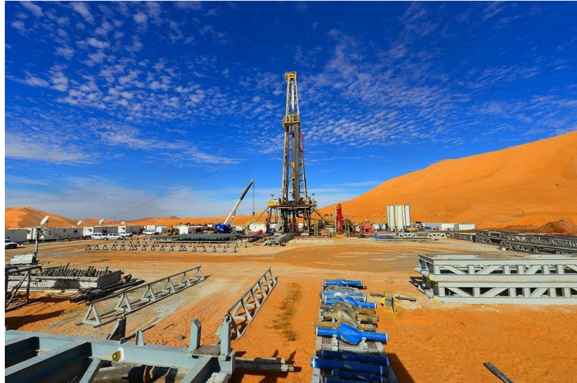
Figure I.3 : Le chantier de l'ENAFOR [1].
