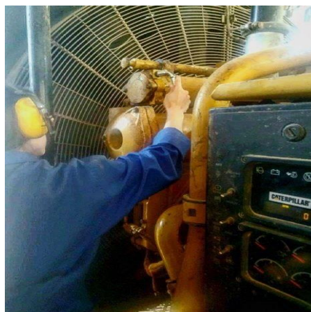
Figure V.14 : Dévissage la vis de purge d'air
