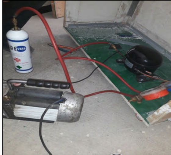
Fig 4.8 : Opération de mise sous vide du circuit de froid
