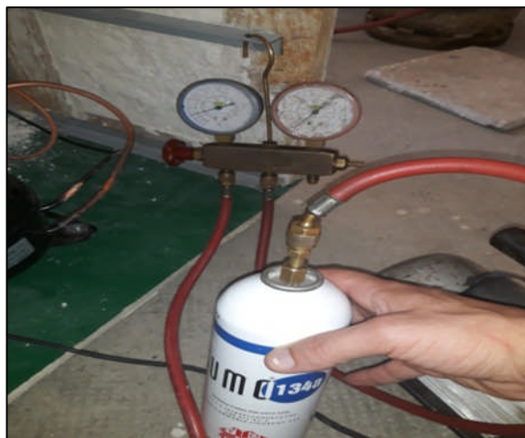
Fig 4.9 : Injection du fréon dans le circuit de froid
