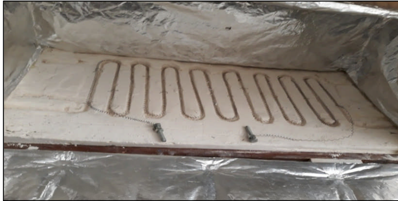
Fig 4.10 : Installation de la résistance chauffante
