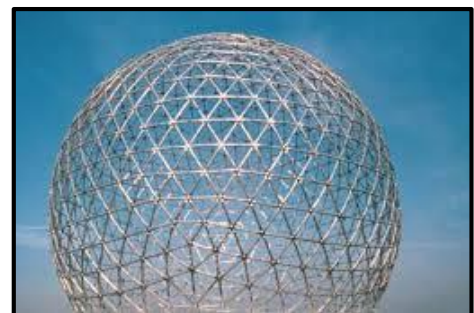
Figure IV.36 : Vue sur la structure géodésique de la géode. Source : www.forumcabasse.com
