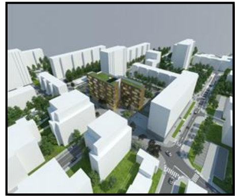
Figure I.7 : vue sur l'aménagement du quartier Source : www.montreuil.fr
