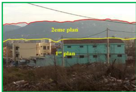
Figure II.50 : vue du site d'intervention vers le Mont Hassnaoua Source: Auteurs
