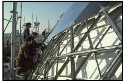
Figure. IV.38: fixation des panneaux bitumés Source : www.lewebpedagogique.com
