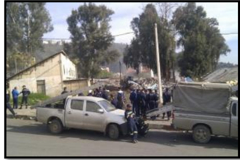
Figure II.58 : 14 novembre 2016 démolition des bidonvilles. Source: www.algerie1.com
