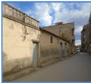
Figure II.34 : maisons traditionnels. Source : auteurs
