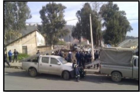
Figure II.18 : 14 novembre 2014, démolition des bidonvilles. Source: www.algerie1.com.
