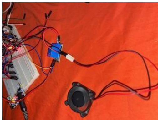
Figure III.28 : déclenchement de ventilateurs
