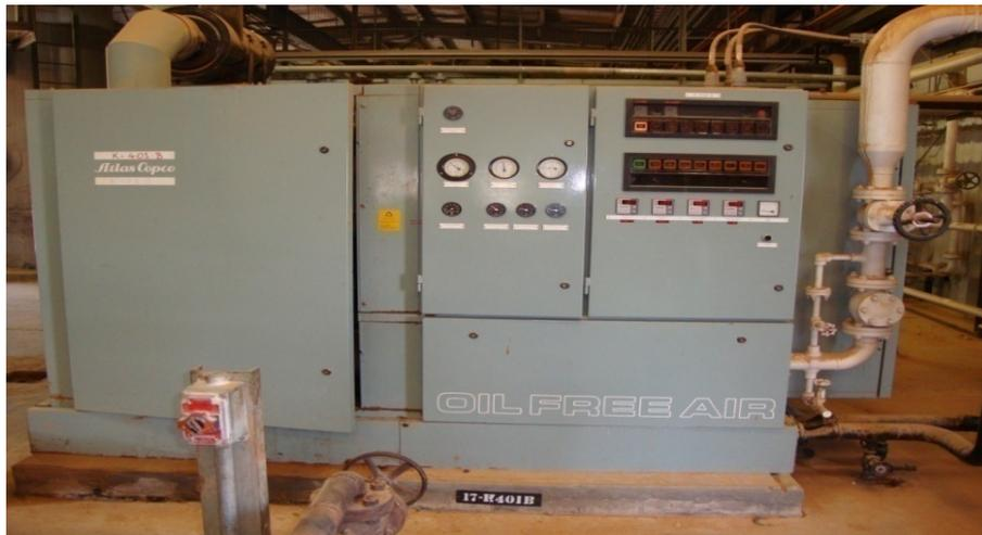
**Figure II.3 Face avant du compresseur à vis**
