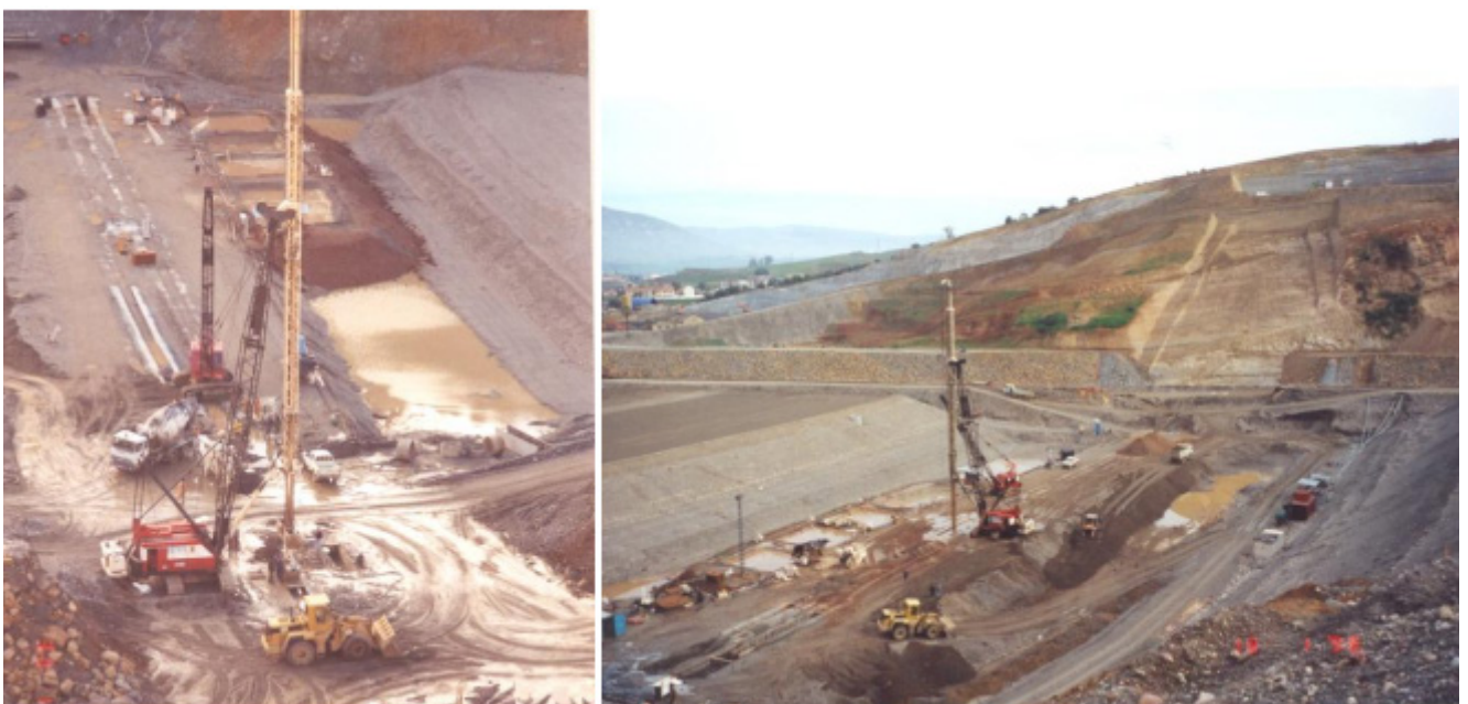
Figure 4.6: travaux de compactage des couches de barrage Taksebt
