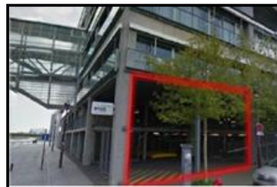
Figure 167: Entrée au batiment Loire Source : cr_nantes_ensa_nantes_mep
