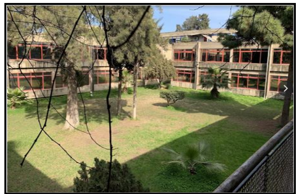
Figure 156: Vue de carré vert Source : Auteurs
