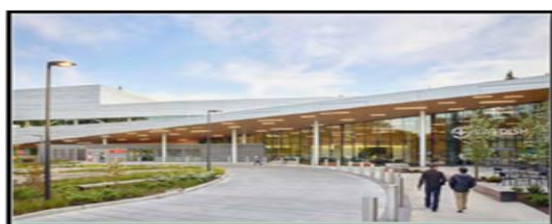
Figure 80: Mise en valeur de l'hôpital
