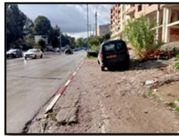
Figure 57: Vue sur l'état des trottoirs Source : Auteurs
