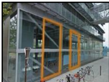
Figure 166/ Entré du bâtiment principal Source : cr_nantes_ensa_nantes_mep
