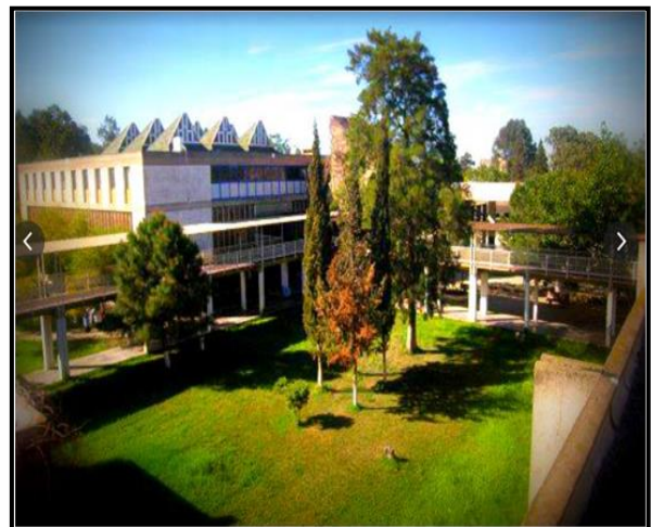
Figure 158: Vue de carré vert Source : Auteurs
