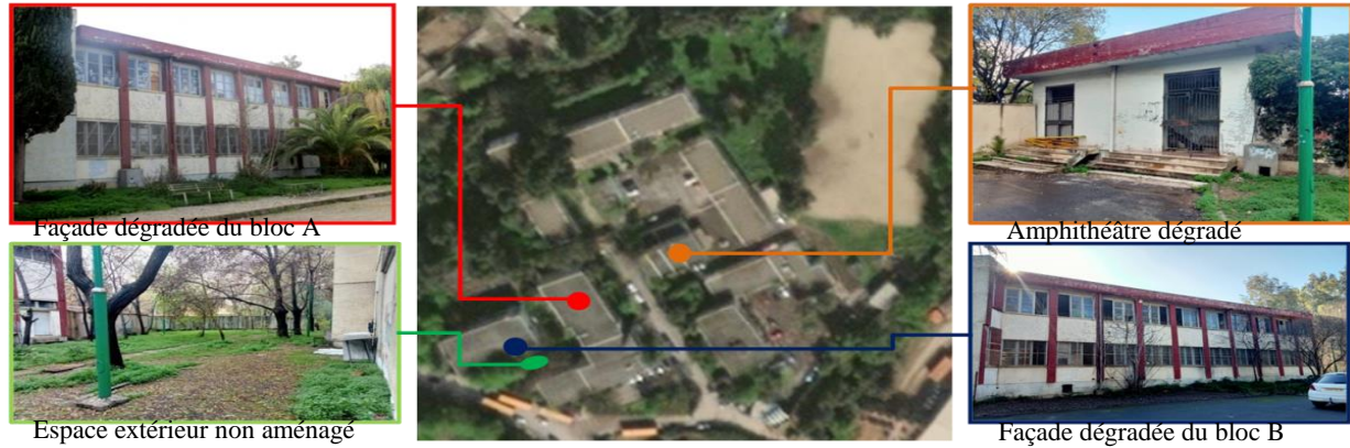
Figure 23: Vue aérienne de l'Ex-Habitat Source : Google earth traité par auteurs
