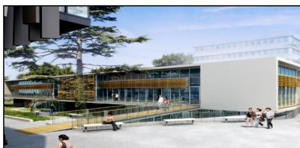
Figure 96: Construction des bâtiments dédiés à la vie du campus Source : https://operation-campus.u-bordeaux.fr/Agir-pour-un-campus-durable/Mobilite .
