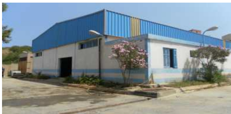
Figure n°3 : Vue générale de la station de dessalement de Tizirt
