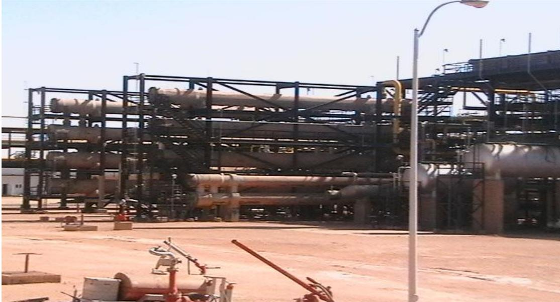
**Figure I.5 : Batterie d'échangeurs.**
